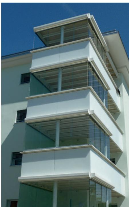
Die Brüstungsgläser sind unten und oben von horizontal durchlaufenden U-Profilen gehalten.
