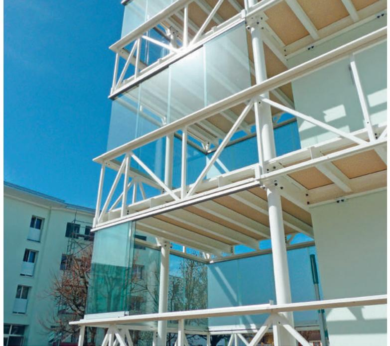
Geländer und Bodenkonstruktion sind zu einer statischen Einheit verbunden. Gut zu erkennen (rechts im Bild) der von der Fassadenecke auskragende UNP-Träger als statischer Stabilisator gegen Torsion. Les balustrades et la structure du sol sont assemblées pour former une unité statique. La poutre UNP (bien visible à droite de la photo) est disposée en porte-à-faux par rapport à l'angle de la façade et agit comme stabilisateur statique contre la torsion.
