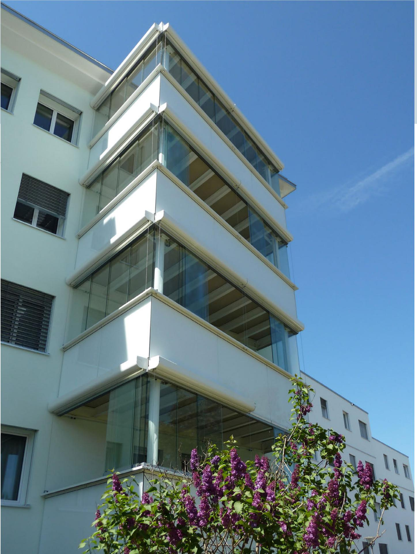
Der statisch weniger anspruchsvolle Balkontyp ist frontseitig in den Eckbereichen abgestützt. Speziell bei diesem Typ ist, dass die Frontseite nicht parallel, sondern schräg zur Fassade verläuft.
