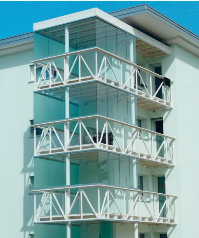
Die Stahlkonstruktion steht, anschliessend erfolgt die Verglasung der Brüstungen. Die Reduktion auf nur zwei Stützen erforderte für die statische Ausbildung der Randträger den Einbezug der Geländer.
