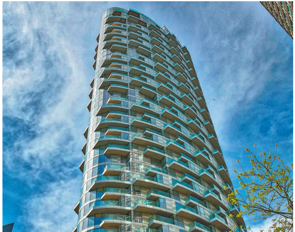
Gutmann realisierte mit dieser Sonderlösung insgesamt 238 Elementfassaden für diesen Wohnturm.
