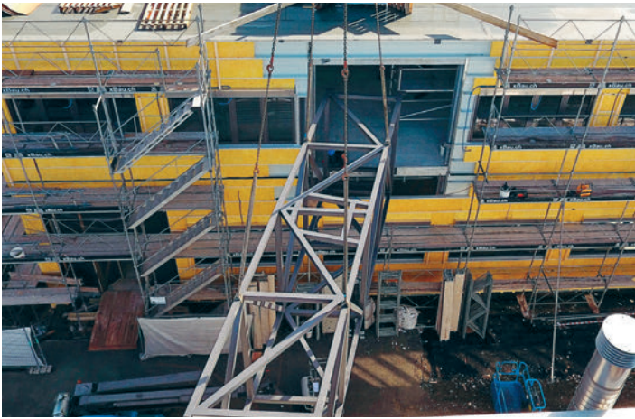
Einbringung Stahlkonstruktion Passerelle. Insertion de la passerelle métallique.
