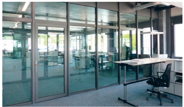
Büroräume mit transparenten Innenabschlüssen. Je nach Auflagen sind diese als Brandschutzfronten EI 30 ausgeführt. Bureaux avec parois intérieures transparentes. Selon les exigences, certaines sont réalisées sous la forme de parois coupe-feu EI 30.
