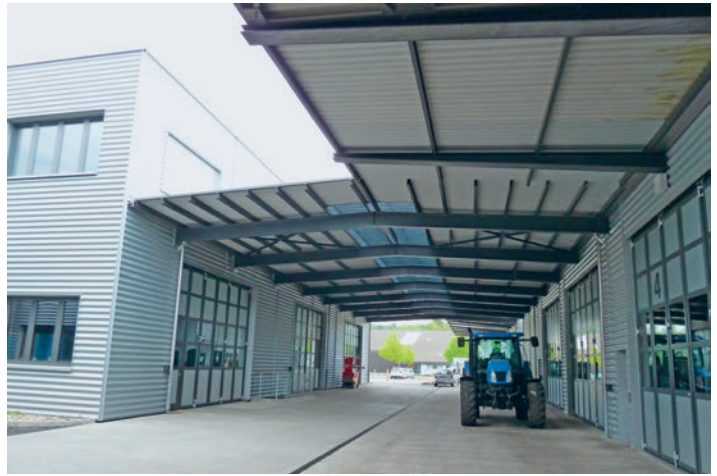
Eine neue Überdachung verbindet das neue, dreigeschossige Gebäude (links) mit dem bestehenden. Un nouveau toit relie le nouveau bâtiment à trois étages (à gauche) au bâtiment existant.
