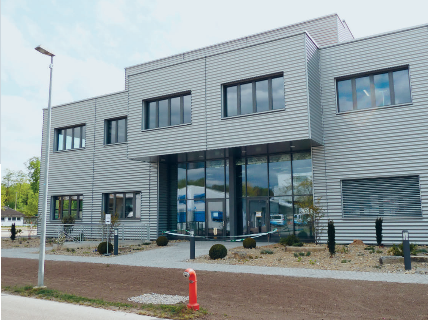
Das neue, dreigeschossige Hauptgebäude: frontseitig die Eingangsfassade mit schützend darüber auskragendem Kubus. Le nouveau bâtiment principal à trois étages : à l'avant, la façade d'entrée avec son cube de protection en porte-à-faux.
