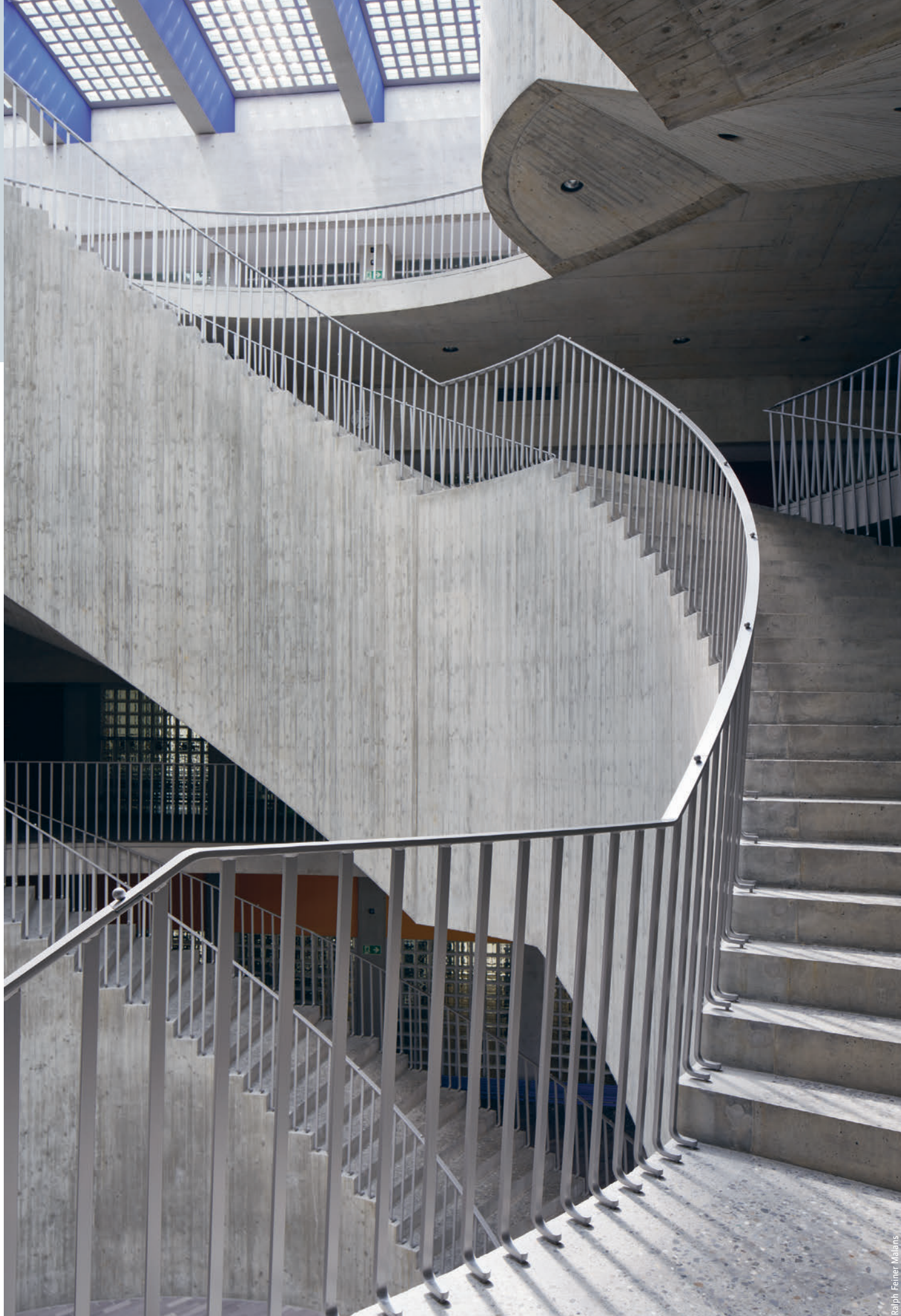
Rund 180 m Geländer mit 1300 abgelenkten Staketten winden sich das offene Treppenhaus empor. Quelque 180 m de balustrades avec 1300 barreaux courbés s'enroulent autour de la cage d'escalier ouverte.
