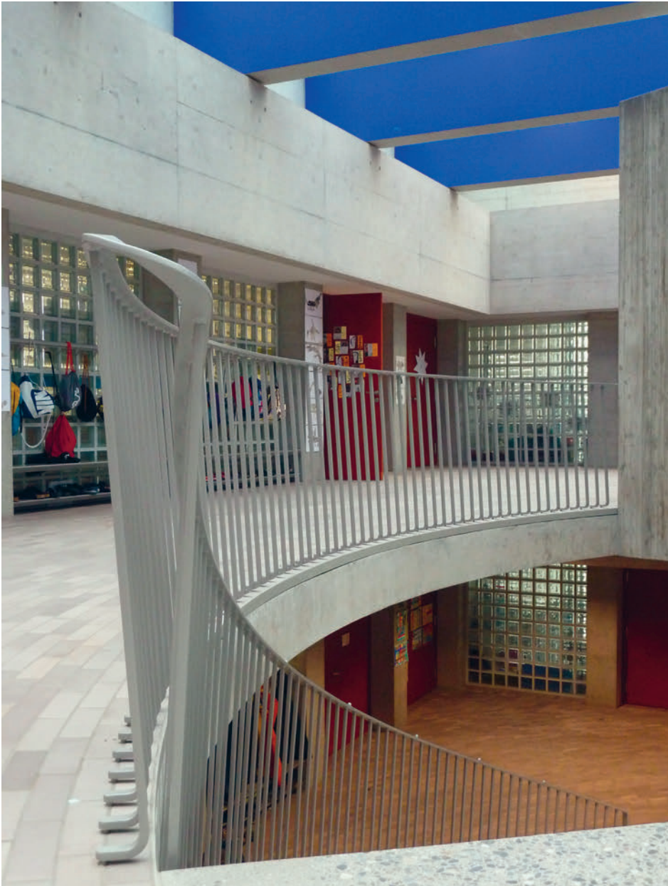
Aus Sicherheitsgründen sind die Staketten gegen die Gehfläche geneigt. Pour des raisons de sécurité, les barreaux sont inclinés vers les marches.
