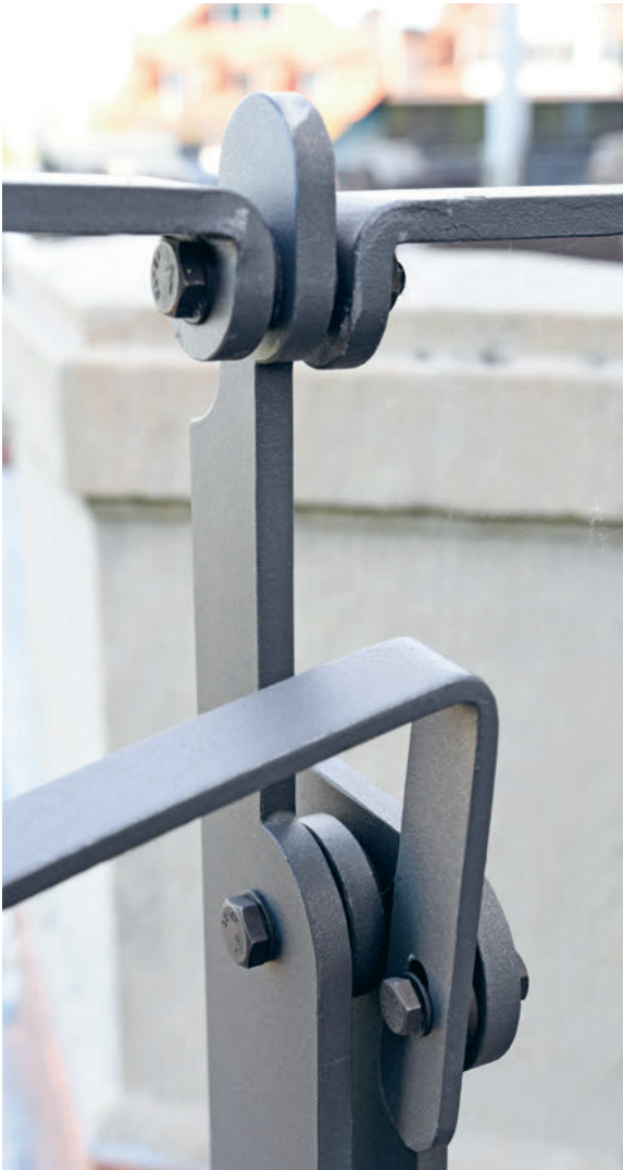
Die Staketen beim Innen- und Aussengeländer sind in den horizontalen Reif gesteckt. Les barreaux des rampantes intérieure et extérieure sont insérés dans le cercle horizontal.
