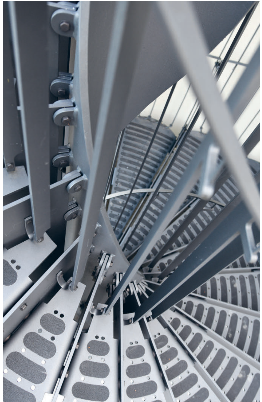
Sicht in das Zentrum: das aufgeschnittene Stahlrohr mit den angeschweissten Befestigungslaschen für die Blechschwerter.
