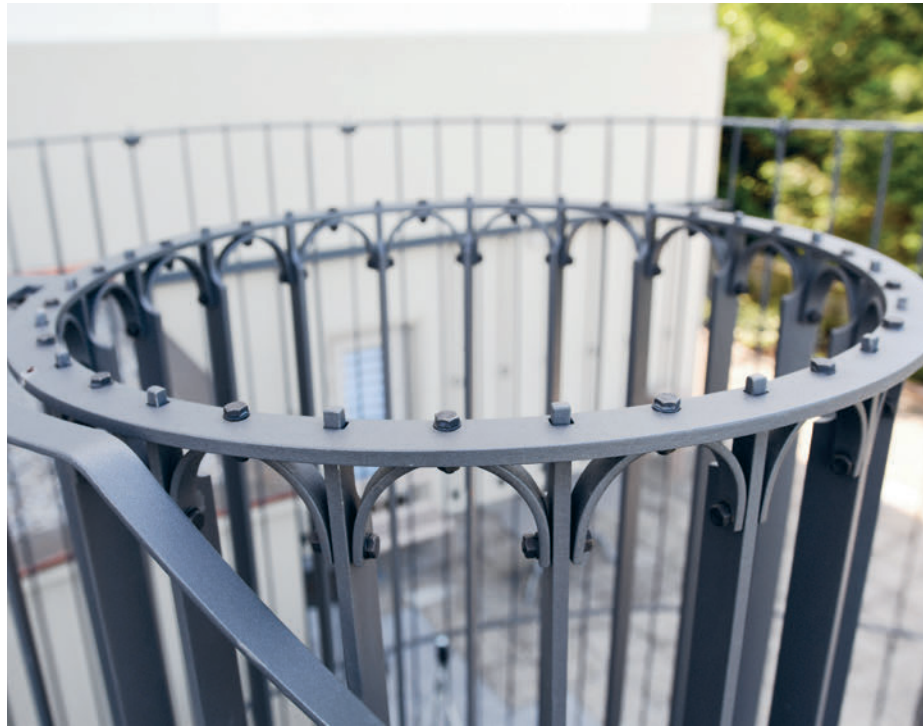
Die Staketen beim Innen- und Aussengeländer sind in den horizontalen Reif gesteckt. Les barreaux des rampantes intérieure et extérieure sont insérés dans le cercle horizontal.
