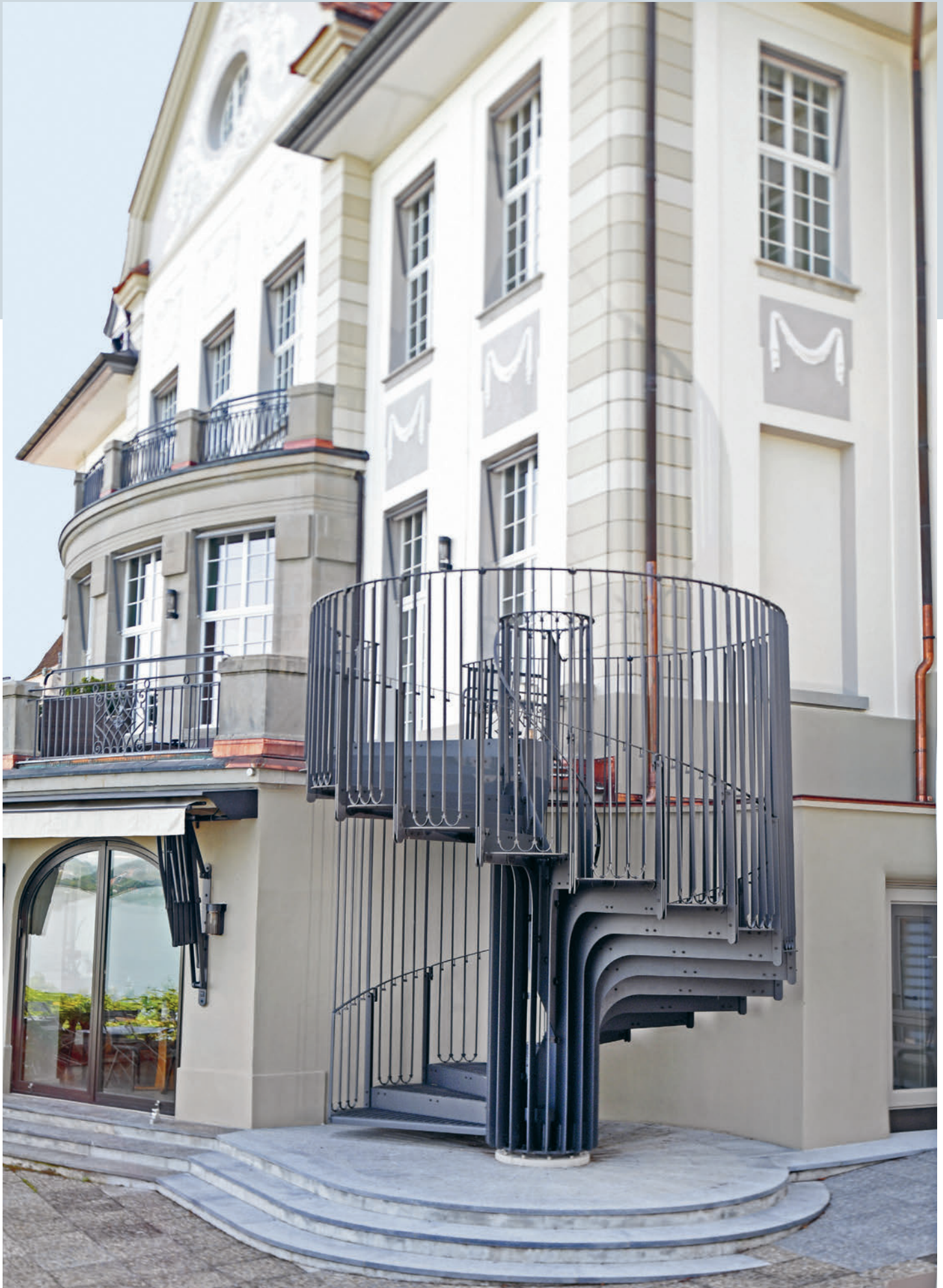
Das filigrane Handwerk der bestehenden Eisengeländer findet seine bildhafte Fortsetzung in der neuen Fluchttreppe. Le nouvel escalier de secours offre un prolongement esthétique de l'ouvrage fin existant, à savoir les balustrades en fer.
