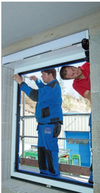
Die dezentrale Lüftung Endura Twist von Renson wird mit dem Fenster verschraubt und als ein Bauteil montiert.
