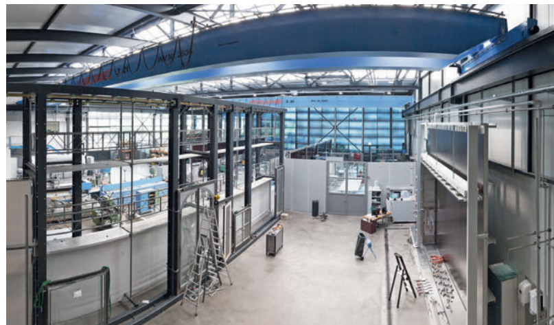
Das Prüfzentrum: Verschiebbare Anschlagkonstruktionen ermöglichen die Prüfung verschiedenster Elemente. Le centre d'essai : des structures à butées déplaçables permettent de tester les éléments les plus divers.
