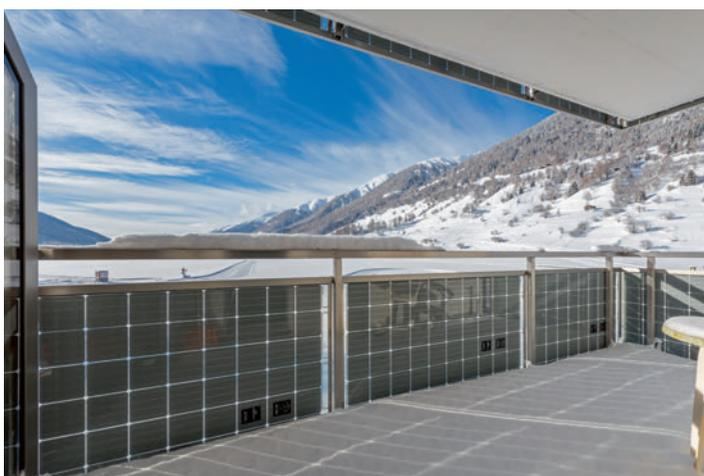
Die Geländerkonstruktion ist aus Edelstahl-Hohlprofilen gefertigt und in technischer sowie ästhetischer Hinsicht einem Standardgeländer ebenbürtig.
