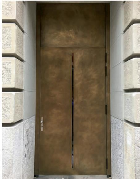
Eine weitere, mit brünierten Messingblechen verkleidete Türe. Ein spezieller Effekt wird durch den vertikal verlaufenden Glasschlitz erreicht. Une autre porte habillée de tôles en laiton bruni. La fente verticale en verre procure un effet spécial.
