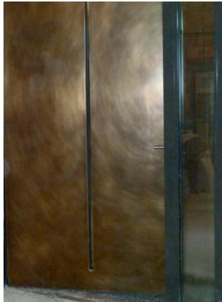
Eine Brandschutztüre während der Montage. Das Türblatt ist bereits mit den brünierten Messingblechen belegt. Die Glasverkleidungen an den Festteilen sind noch ausstehend. Une autre porte pare-feu pendant le montage. Le vantail est déjà garni de tôles en laiton bruni. Les habillages en verre des éléments fixes sont encore attendus.
