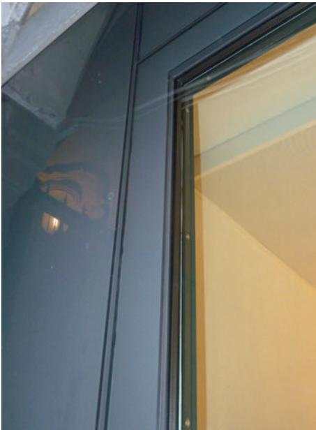
Detailansicht einer Brandschutztüre. Rahmen und Flügel sind beidseitig zusätzlich mit teilemailliertem Einscheibensicherheitsglas belegt. Vue détaillée d'une porte pare-feu. Le châssis et le battant sont garnis des deux côtés de verre de sécurité trempé partiellement émaillé.
