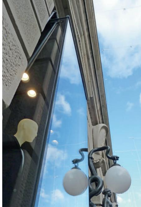
Die geklebten Ganzglasecken verleihen den
