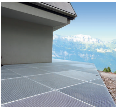
Als tragendes Gerippe dient eine auf Pfeilern abgestellte Grundkonstruktion aus IPE-80-Profilen.
