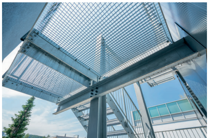
Für sämtliche Gehflächen wurden Maschenweiten von 33 x 33 mm gewählt.
