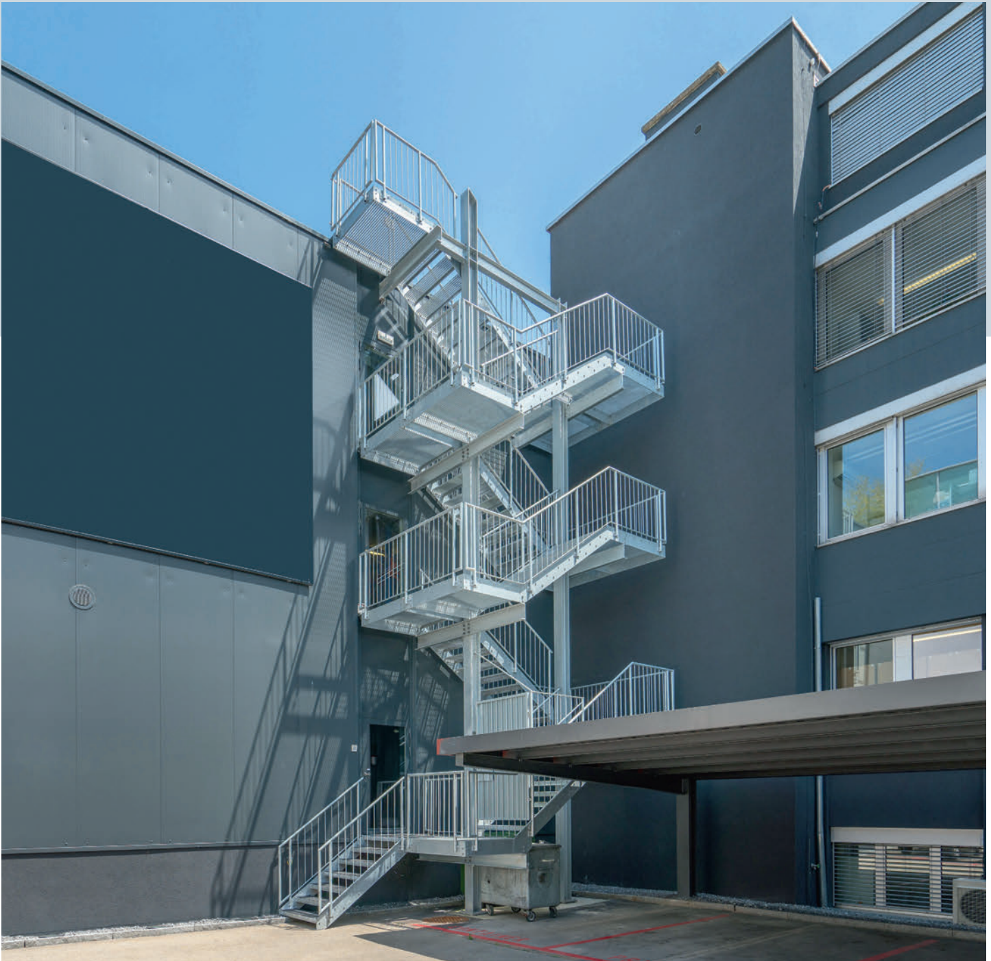
Der mit Gitterrosten belegte Treppenturm erschliesst vier Geschosse und misst 12 Meter in der Höhe.
