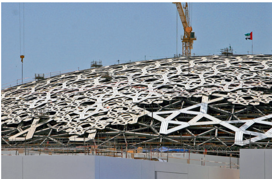
Die Oberseite und die Unterseite der Kuppel sind mit je vier Ebenen aus kreuzförmigen, unterschiedlich grossen Aluminiumprofilen bedeckt.
