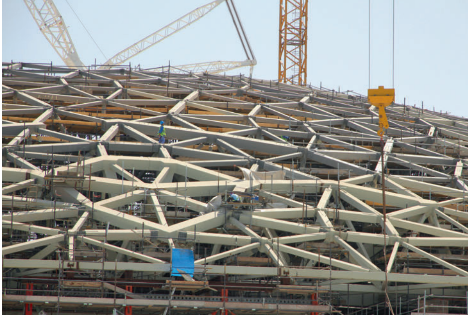
Die gesamte Kuppel wurde in 85 kastenförmige Elemente aufgeteilt und so zusammengesetzt.
