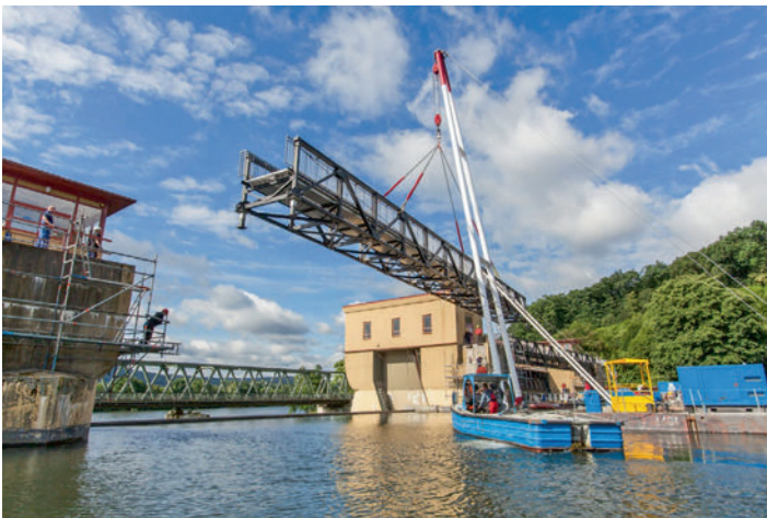
Der Kran hob die alten Brückenelemente nacheinander - beginnend mit dem ersten Wehrfeld auf der Herdecker Uferseite - aus ihrer Verankerung, schwenkte sie über das Wasser, legte sie an Land ab. La grue a soulevé successivement les anciens éléments de passerelle de leur ancrage, en commençant par le premier pertuis sur la rive située du côté d'Herdecke. Elle les a ensuite fait pivoter au-dessus de l'eau avant de les déposer à terre.
