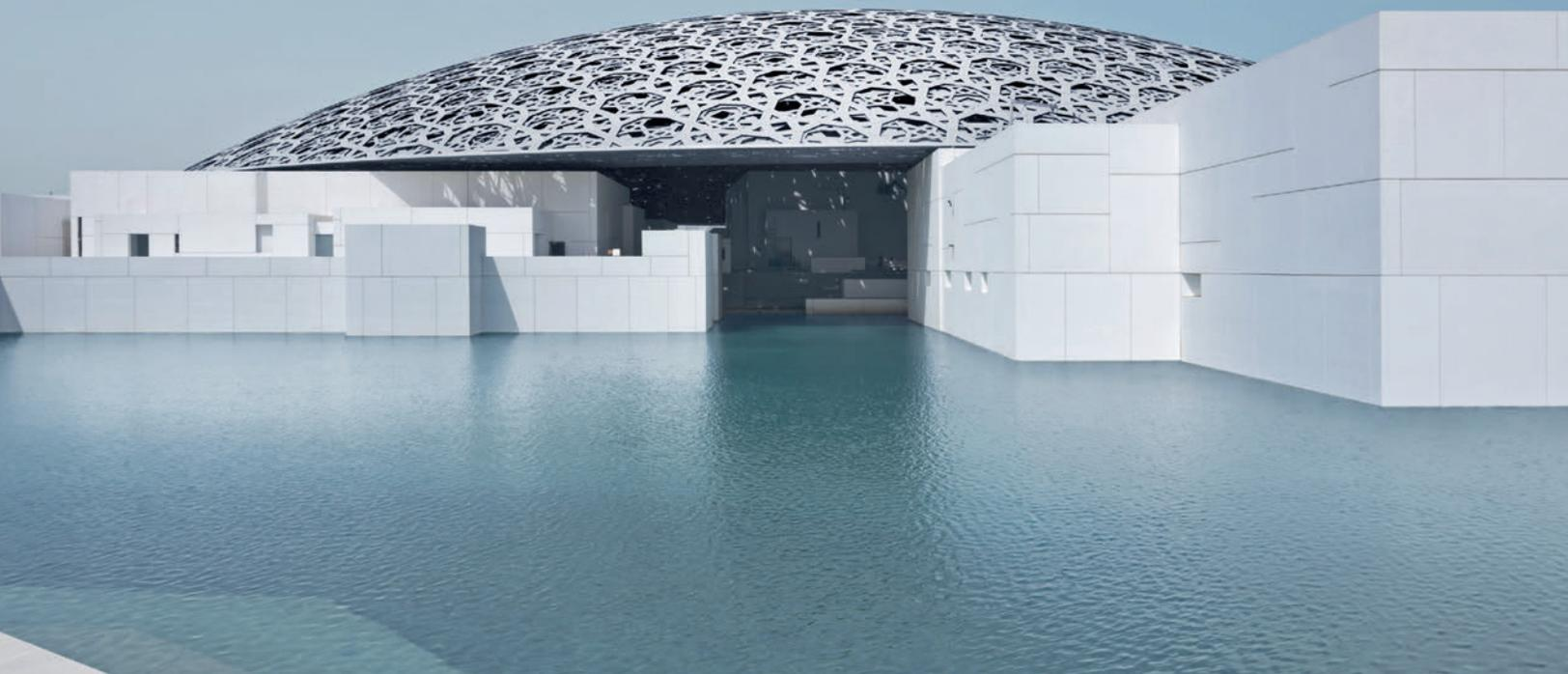
Die Kuppel mit einem Durchmesser von 180 Metern besteht aus acht Schichten Stahlornamenten. Bild: Mohamed Somji
