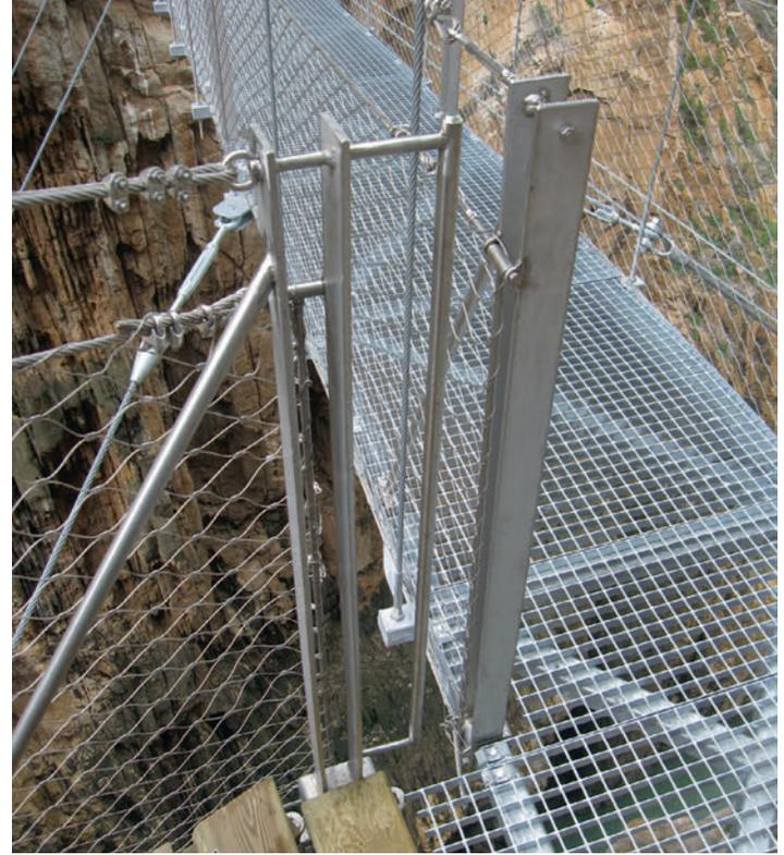
Der Laufsteg ist mit Holz belegt, die Brücke mit Gitterrosten.
