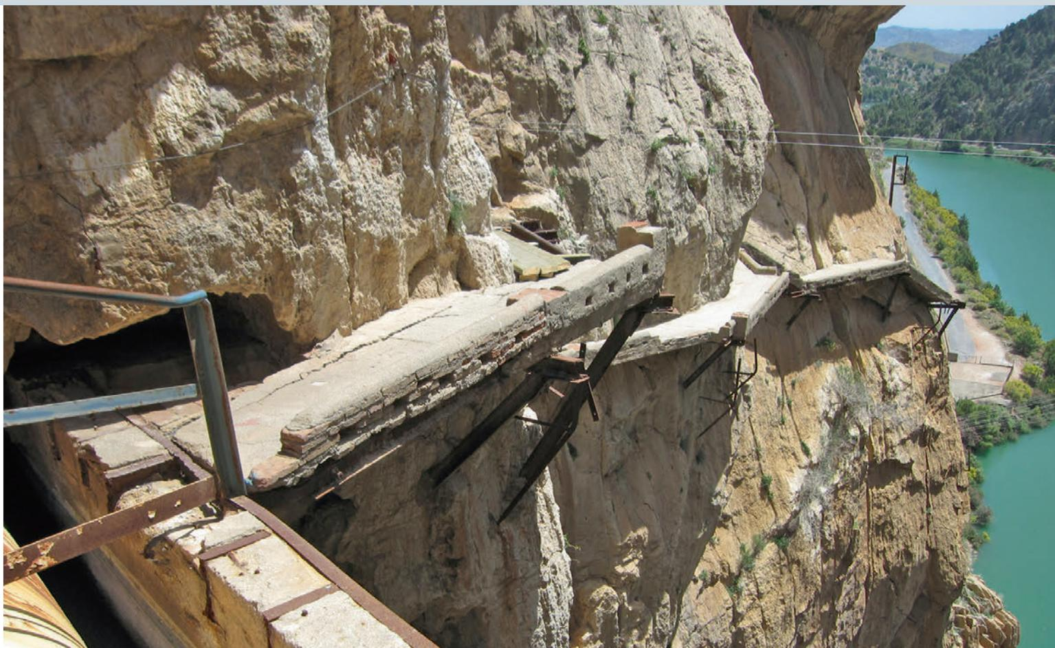
Der alte, beschädigte Pfad wird durch einen neuen Stahlsteg ersetzt.
