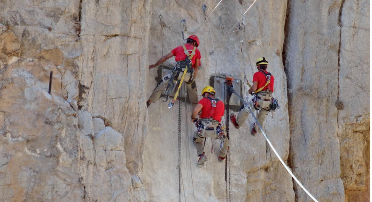
Verankerung der Zugplatte für eine Hängebrücke, die einen Teil des neuen Stegs bildet.
