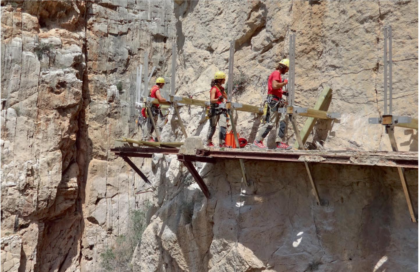
Der alte Pfad konnte bei den Montagearbeiten des neuen Stegs als Stehfläche genutzt werden.
