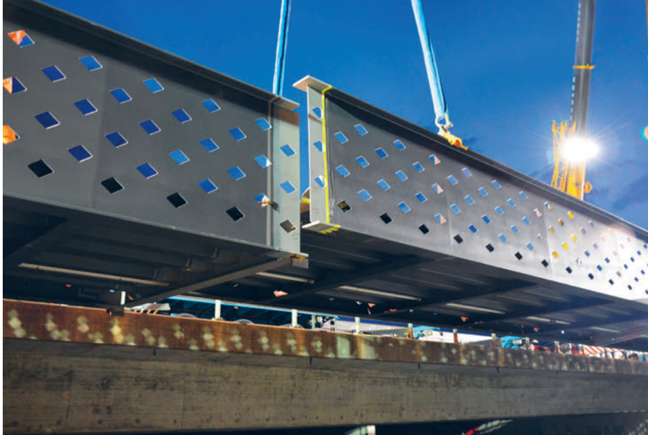
Anschliessend erfolgte die Verschweissung vor Ort. Si è quindi proceduto alla saldatura completa in loco.
