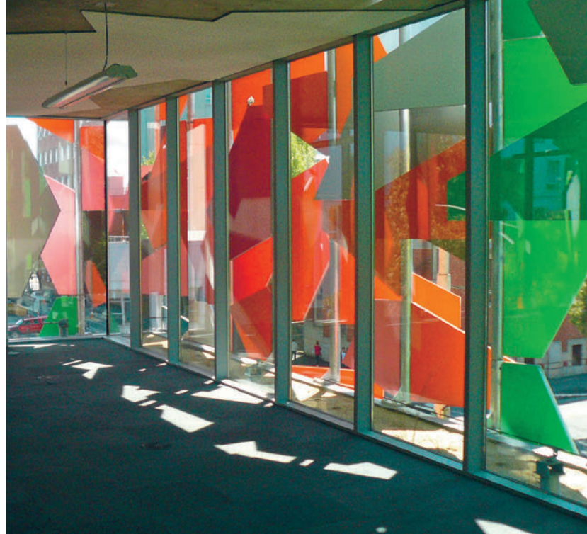
Abbildung 2: Beispiel eines parametrisch generierten Fassaden-Sonnenschutzes, der an den lokalen Sonnenverlauf angepasst wurde und damit passiv-adaptiv agiert. Pixel Gebäude, Architekten Studio 505, Melbourne, Australien. Quelle © S. Gosztonyi.
