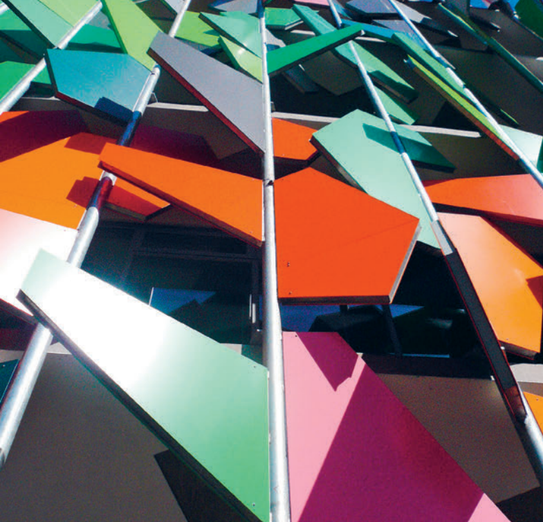
Abbildung 2: Beispiel eines parametrisch generierten Fassaden-Sonnenschutzes, der an den lokalen Sonnenverlauf angepasst wurde und damit passiv-adaptiv agiert. Pixel Gebäude, Architekten Studio 505, Melbourne, Australien. Quelle © S. Gosztonyi.
