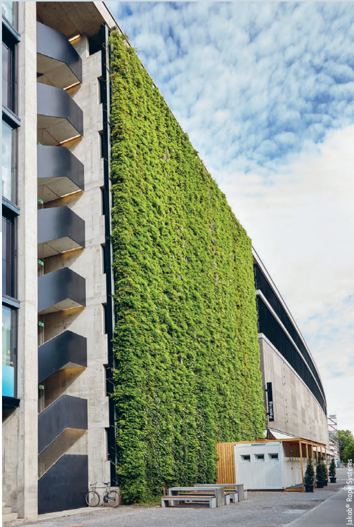
Abbildung 2: Die in dieser Abbildung gezeigte, 600 m 2 grosse Rankhilfe (25 × 24 m) ist ein Beispiel einer bodengebundenen Gebäudebegrünung von Jakob Rope Systems am Parkhaus Sihlcity, Zürich.
