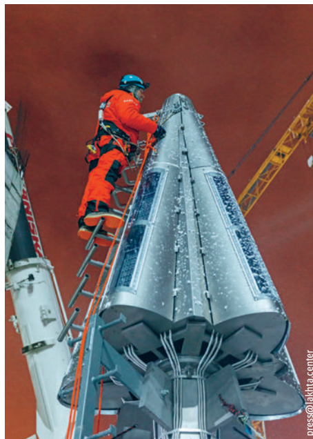
Montage der 13 m hohen Turmspitze in 300 m Höhe. Gesicherte Alpinisten unterstützten die Monteure.
