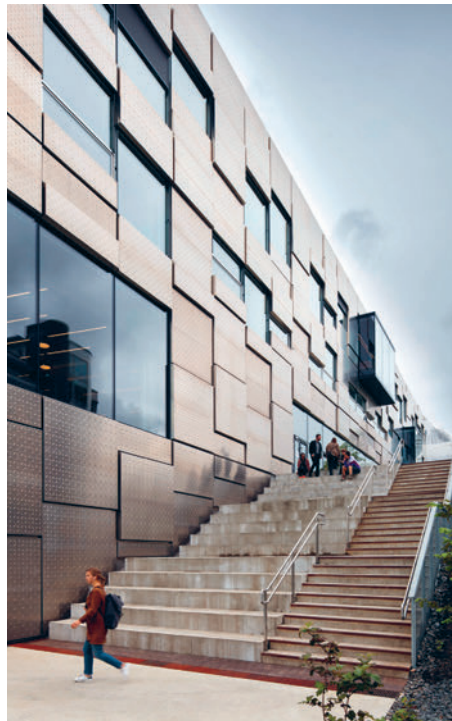
Das rohe Aluminium ist salzwasser- und witterungsbeständig. L'aluminium brut est résistant au sel de mer et aux intempéries.
