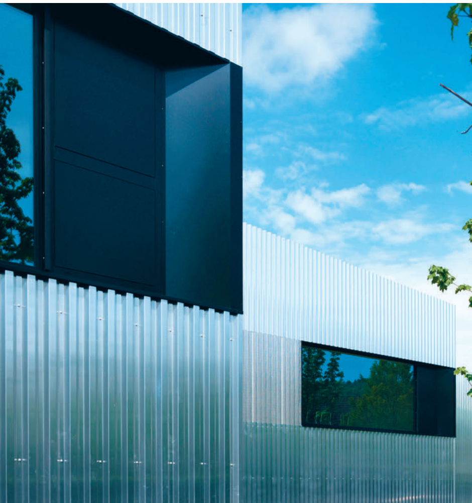
Die grossen Panoramafenster schaffen eine Beziehung zwischen innen und aussen.
