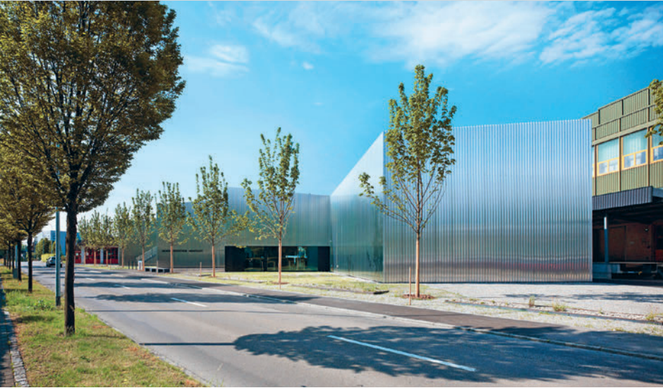
Die Abtrepfung der Fassade schafft in optischer Hinsicht eine diskrete Annäherung an die Wohnbauten auf der anderen Strassenseite.
