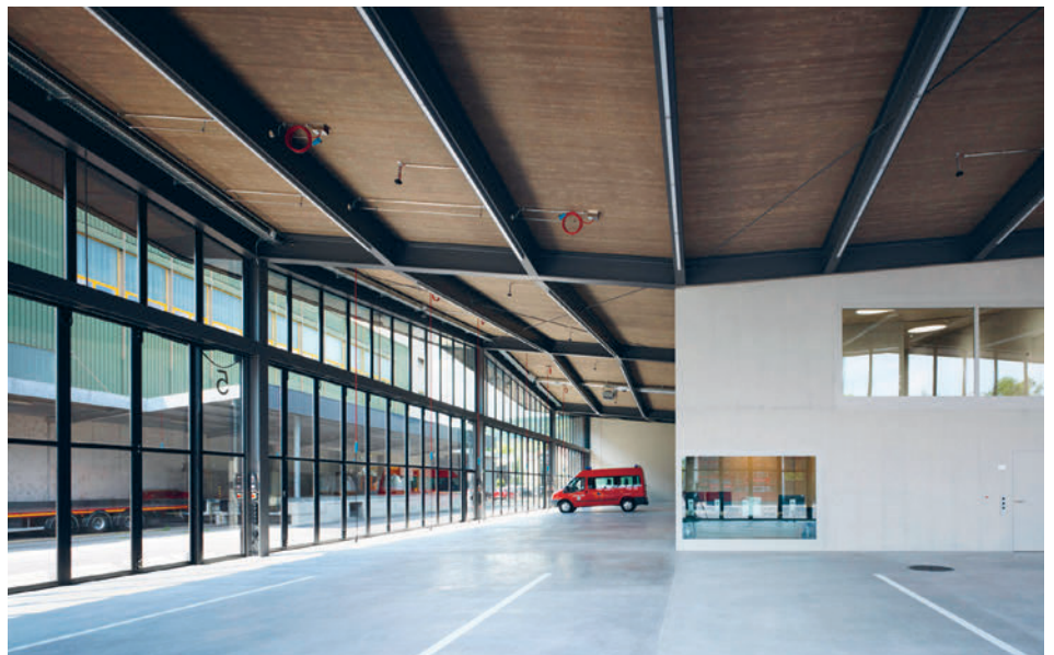
Die hochtransparenten, automatisierten falt-schiebetore sorgen für eine hohe Lichtdurchflutung und im Notfall schnellstes Ausrücken.
