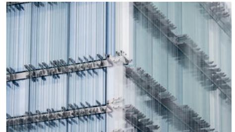
Die Gebäudehülle besteht aus einer Dreifach-Isolierverglasung, die durch eine vierte, belüftete Schicht ergänzt wird, in die eine mikroperforierte Jalousie integriert ist.
