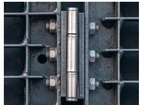
Anschraubänder aus Edelstahl ermöglichen ein einfaches, bequemes Aufklappen einzelner Roste.
