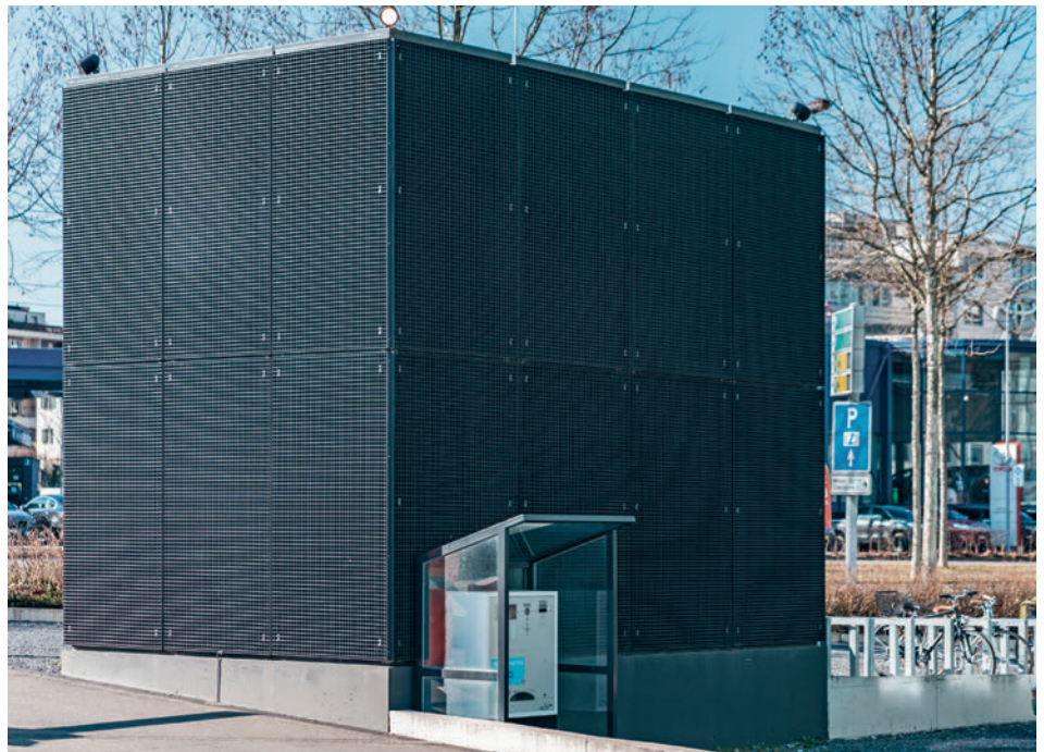
Vollroste setzen optische Akzente und bieten gegenüber Pressrosten einen erhöhten Sichtschutz.
