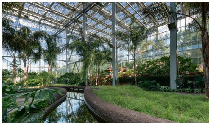
Der Neubau besteht aus einem 50 m langen Stahlwerk mit nur einer Reihe Mittelstützen. Le nouveau bâti se compose d'une structure en acier de 50 m de long assortie d'une seule rangée de piliers centraux.
