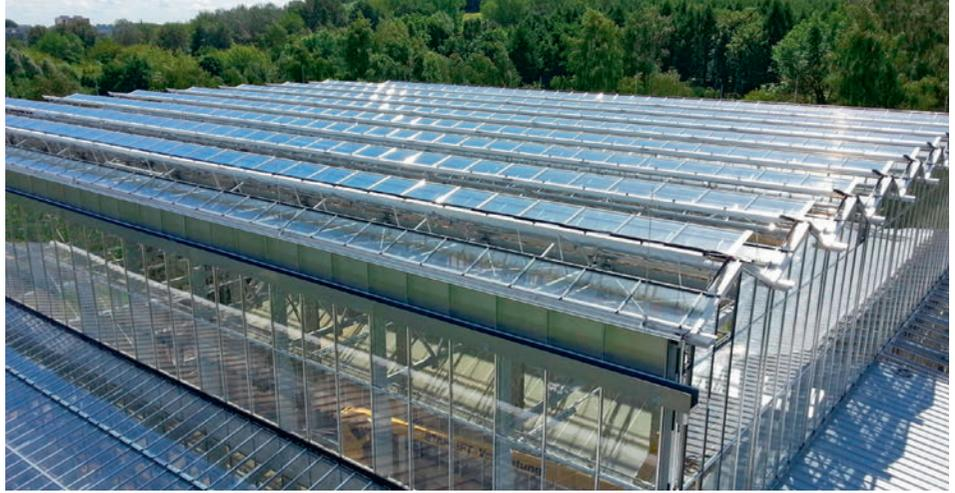
Die neue Isolierverglasung reduziert in Kombination mit der modernisierten Gebäudetechnik den Energiebedarf für die Heizung um mehr als den Faktor 10. Associé à une technique du bâtiment modernisée, le nouveau vitrage isolant réduit les besoins énergétiques de chauffage d'un facteur supérieur à 10.
