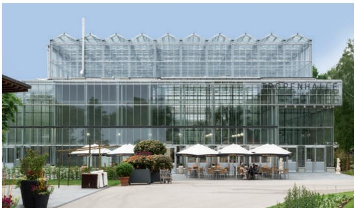
Als Haus-in-Haus-Bauweise wurde die Erweiterung der Tropenhalle um das ursprüngliche Bauwerk errichtet. La halle tropicale a été érigée autour de l'ouvrage original sur le modèle des constructions gigognes.
