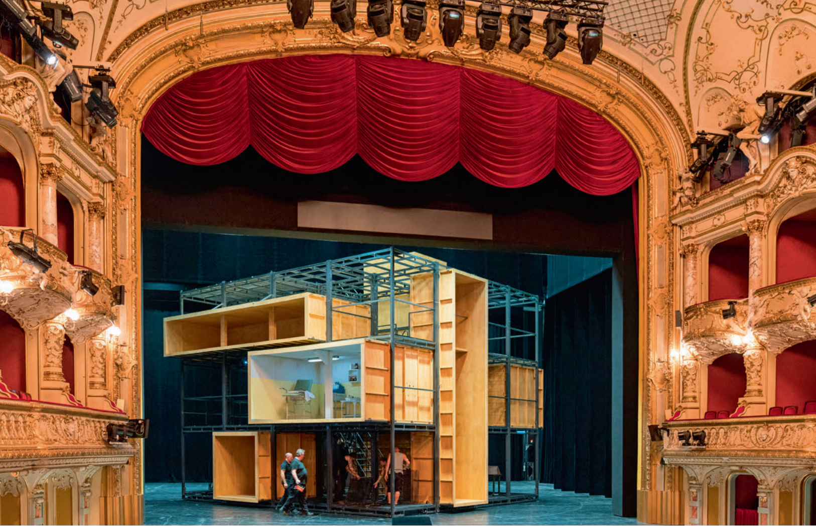
Für die Bodenbelegung kamen gefärbte GFK-Gitterroste zur Anwendung.
