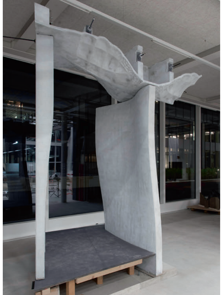
So - geschwungen und verwunden - wird sich die mit Stahl armierte Betonwand präsentieren. Le mur en béton armé se présente ainsi, courbé et gauchi.
