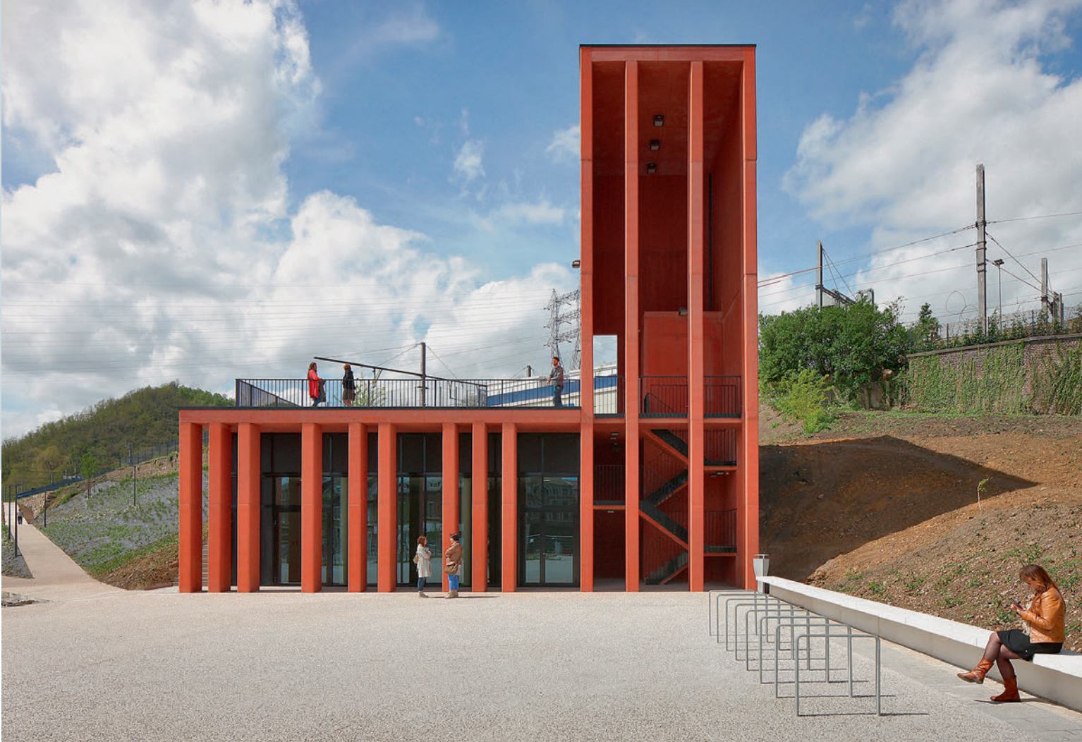
Der Turm, der gestalterisch als Landmarke fungiert, beherbergt eine Treppen- und Aufzugsanlage für die vertikale Erschließung. La tour, qui sert de point de repère, abrite un escalier et un ascenseur qui desservent les étages.
