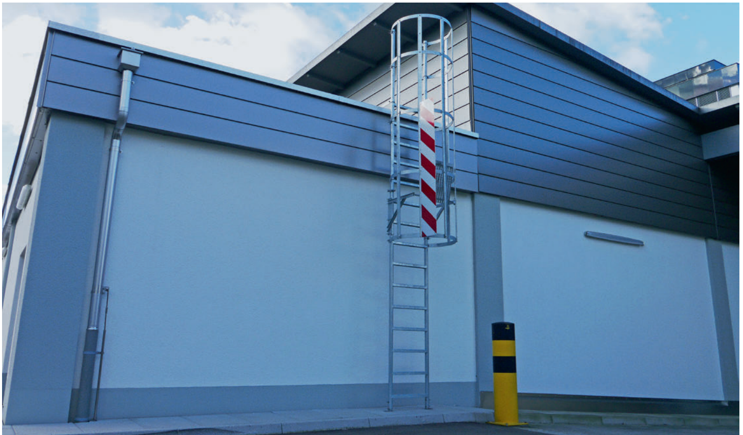
Sprich rüstete 15 Lidl-Filialen mit speziellen Steigleitern aus, versehen mit Rückenschutz.
