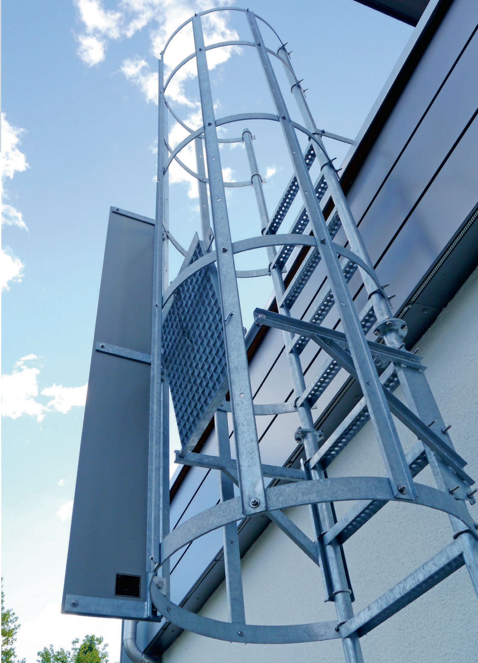
Eine spezielle Anforderung bildete die Befestigung im Bereich des Dachrandes.
