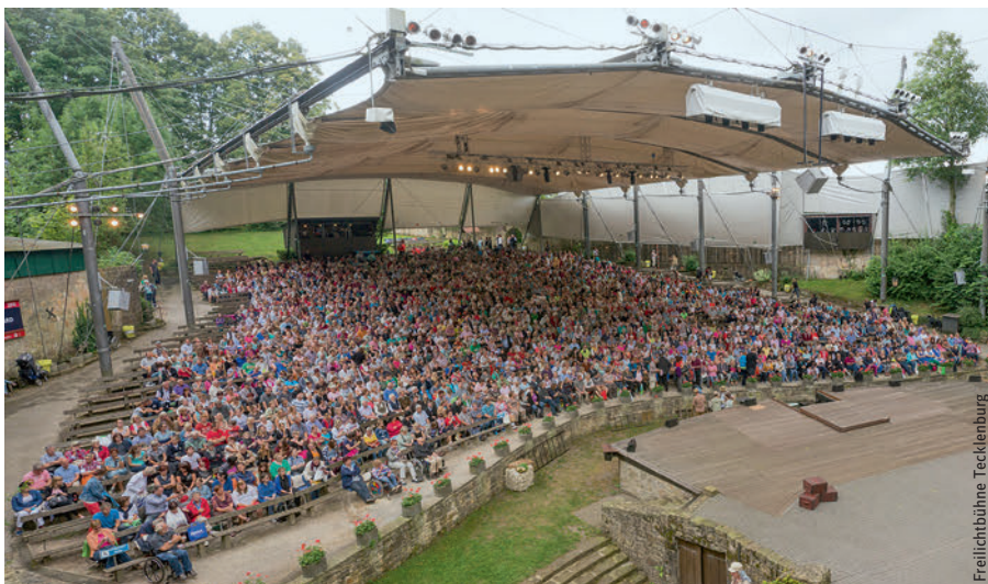
Die Überdachung vor der Sanierung. La toiture avant la rénovation.
