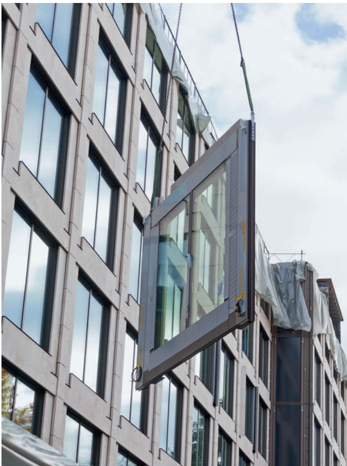
Objekt Alfred-Escher-Strasse, Zürich: Das Element am Kran misst 4,2 × 3,5 Meter und wiegt rund 2,5 Tonnen. Projet situé Alfred-Escher-Strasse, à Zürich : l'élément sur la grue mesure 4,2 × 3,5 m et pèse environ 2,5 t.
