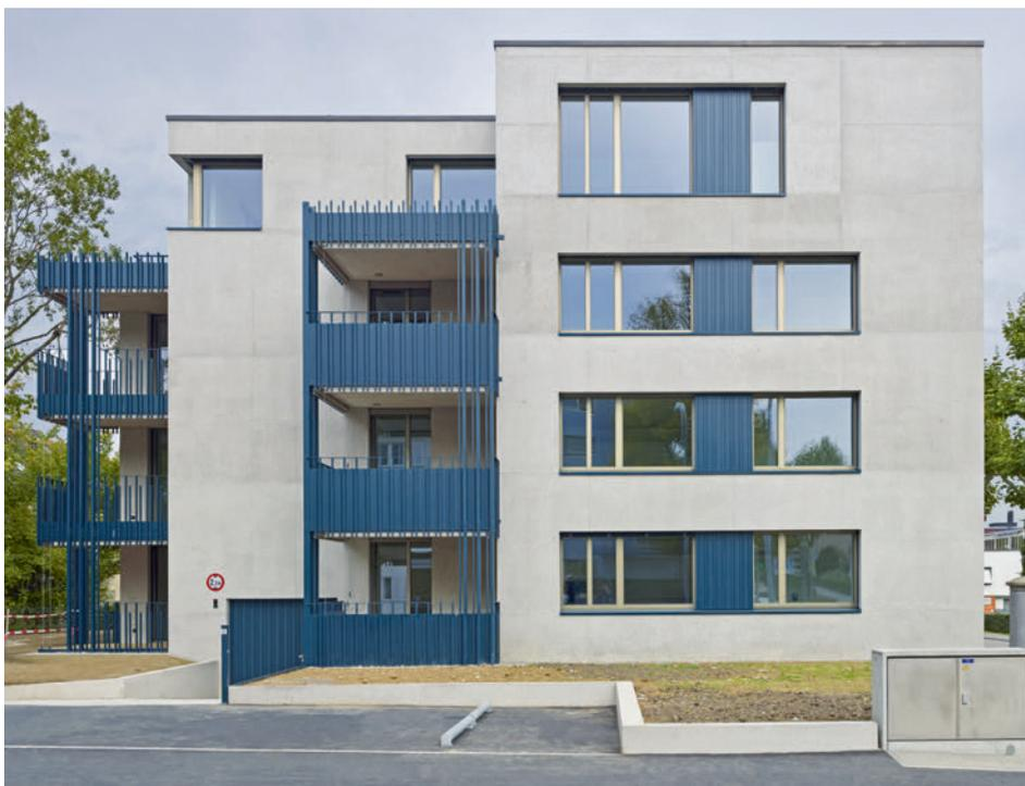
Beim Balkonturm zur Strasse hin sind die Schürzenbleche höher geführt und bilden so einen Sichtschutz. Les tôles de tabliers des balcons côté rue sont relevées pour créer une protection contre les regards.
