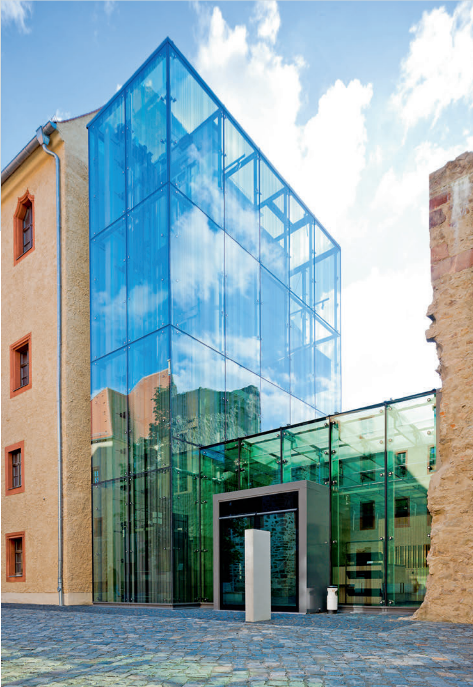
Glasfassade am Schloss Grimma (D). Punktgehaltenes Sonnenschutzglas mit Siebdruck für den Treppenturm.
