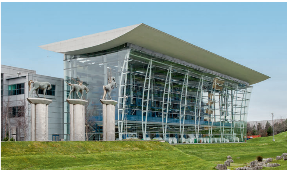
Konstruktiver Glasbau bei der Fassade einer Druckerei in Irland.
