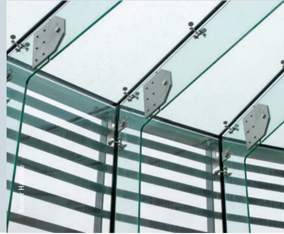
Innenansicht einer punktgehaltenen Fassade mit einer tragenden Stützkonstruktion aus Glas.
