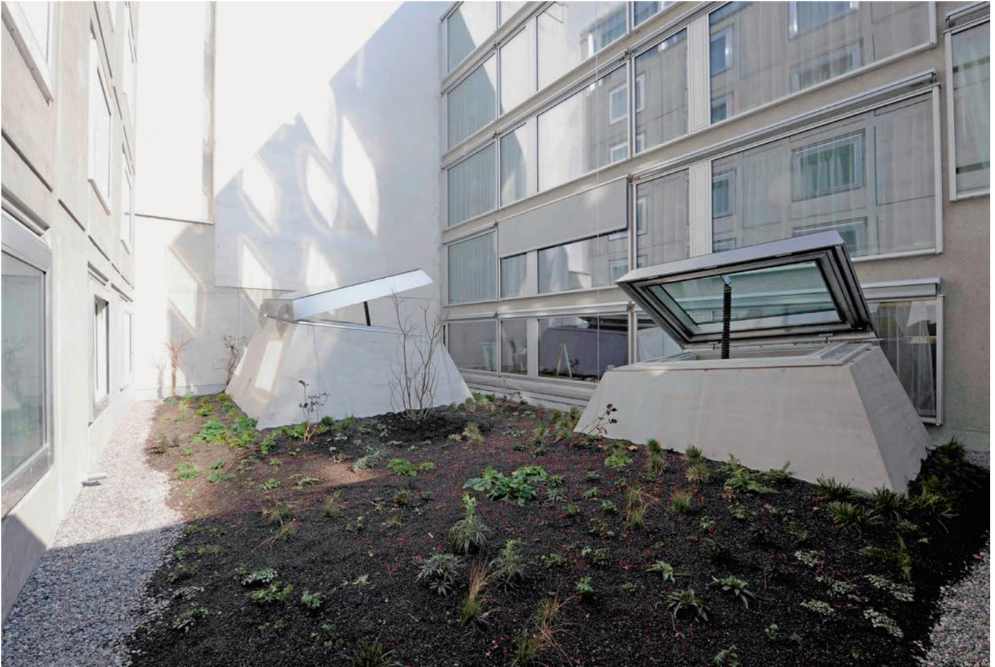
Die beiden Oberlichter über der Lounge: Angetrieben von einem 20-kN-Zahnstangenantrieb lassen sie sich zu Lüftungszwecken öffnen.
