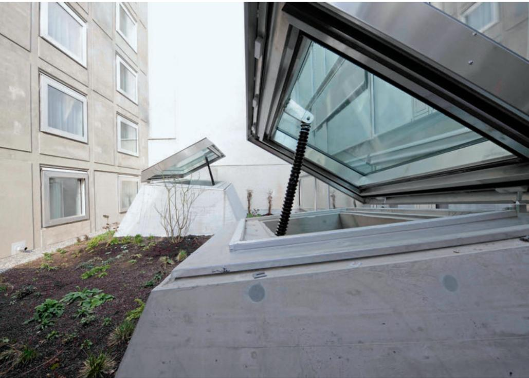
Die Blechzarge dient als Auflager und gewährleistet eine kontrollierte Entwässerung gegen aussen.
