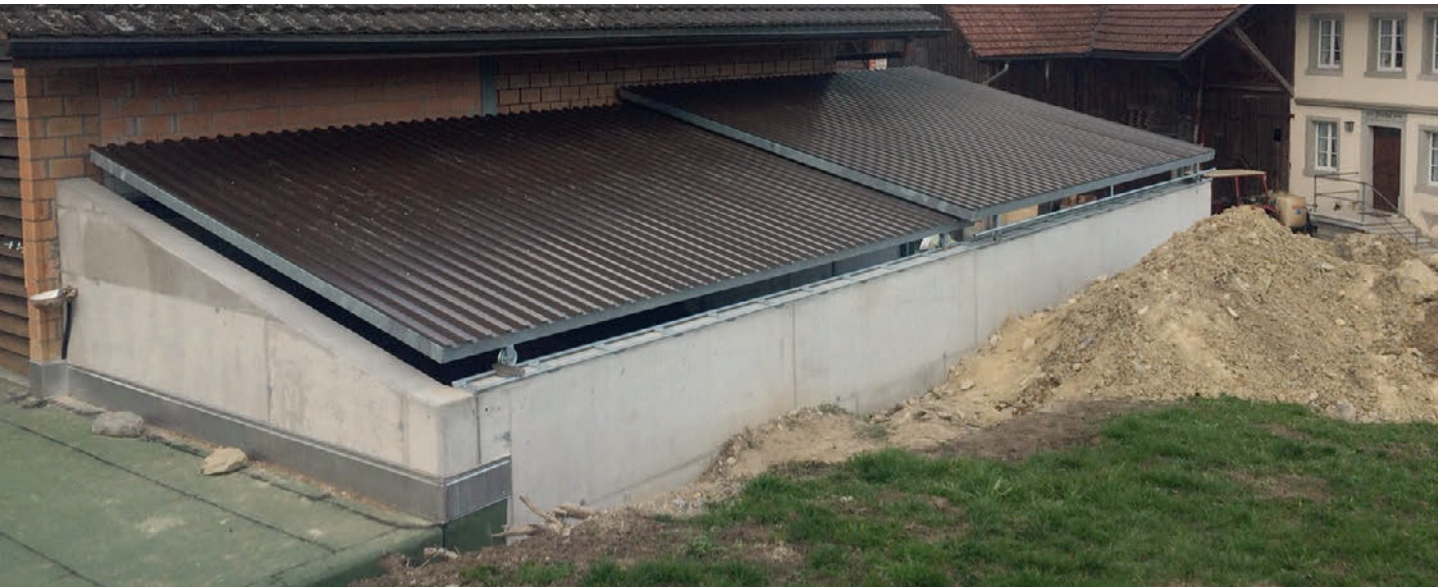
Das massive Schiebetor wiegt mehr als 2 Tonnen und dient als Abdeckung für einen sogenannten Schnitzelbunker.
