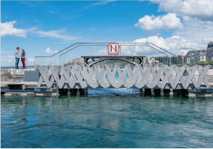
Durch Zusammenschieben der Scherenelemente flacht die Brücke ab.
