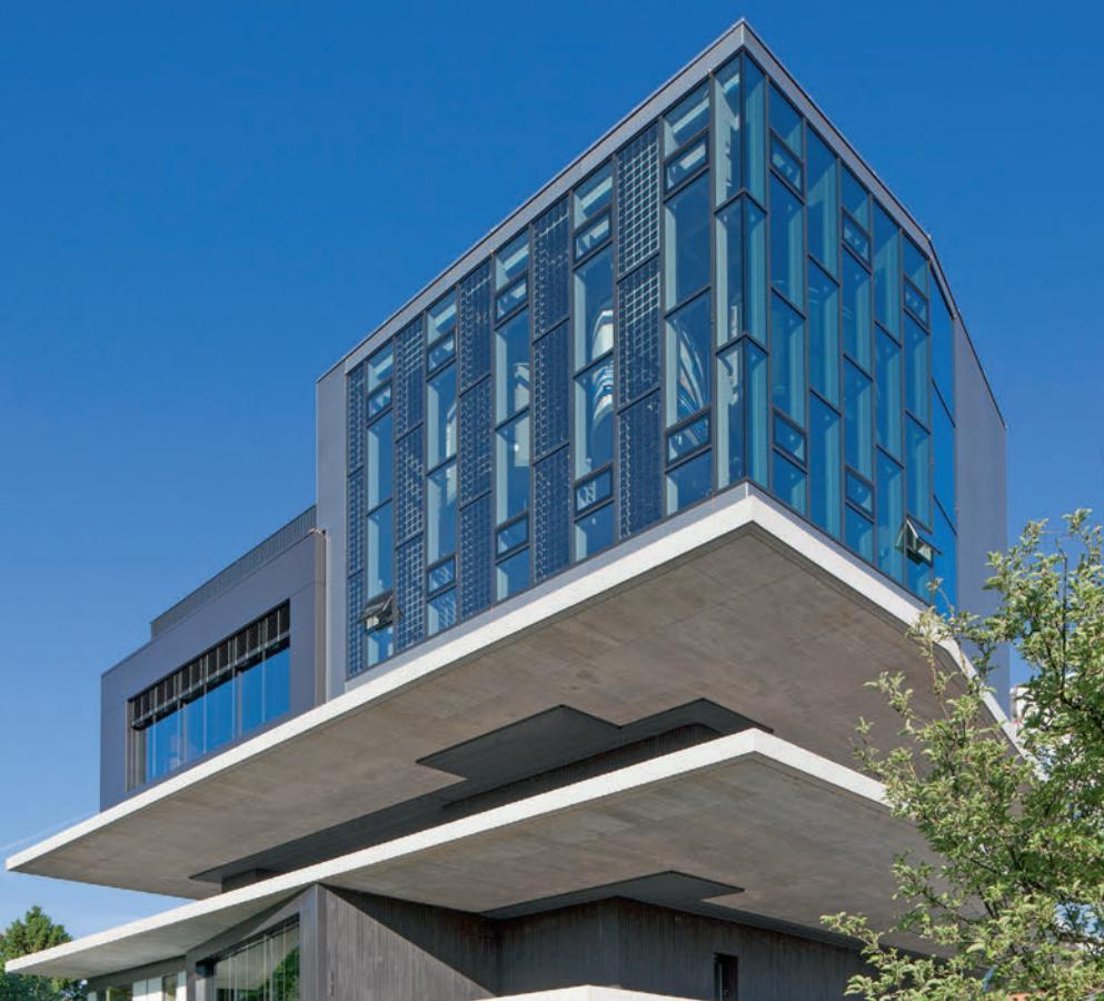
Das Holz/Metall-Pfosten-Riegel-System «Raico Therm M+ H-V» von Schweizer am NEST in Dübendorf.
