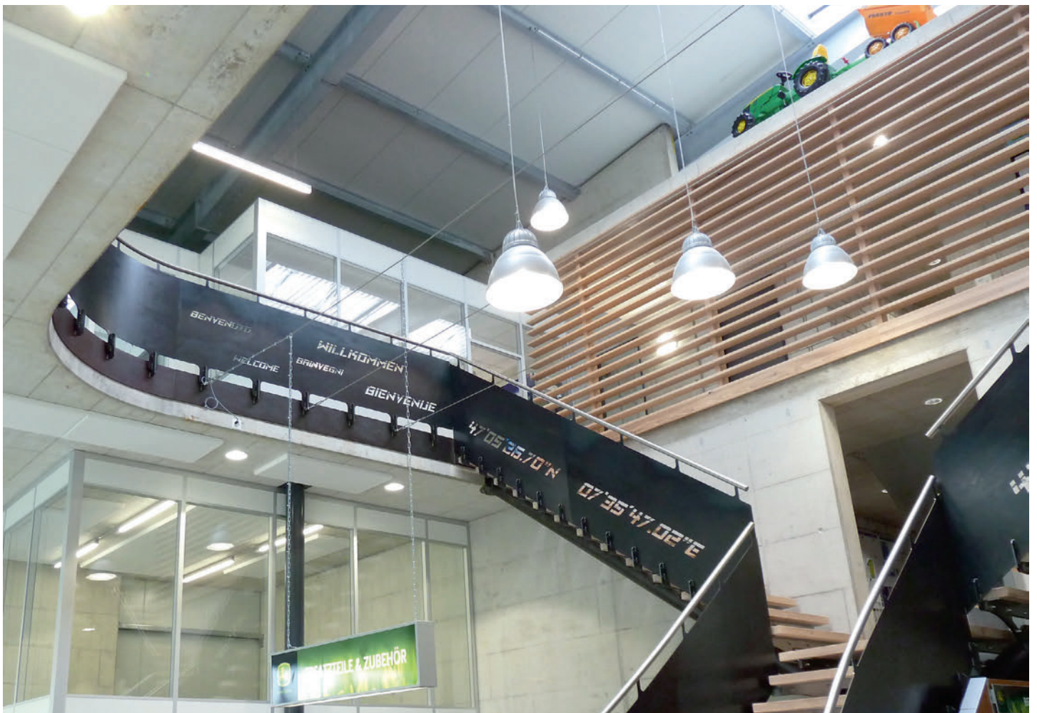
Die Podestgeländer umschliessen den Luftraum vierseitig. Sie bestehen aus einer Boden-Abschlusszarge aus 10-mm-Stahlblechen, das in den Ecken im Radius gebogen ist. Les balustrades du palier délimitent l'espace ouvert de quatre côtés. Elles intègrent un encadrement au sol en tôles d'acier de 10 mm courbées en rayon dans les angles.
