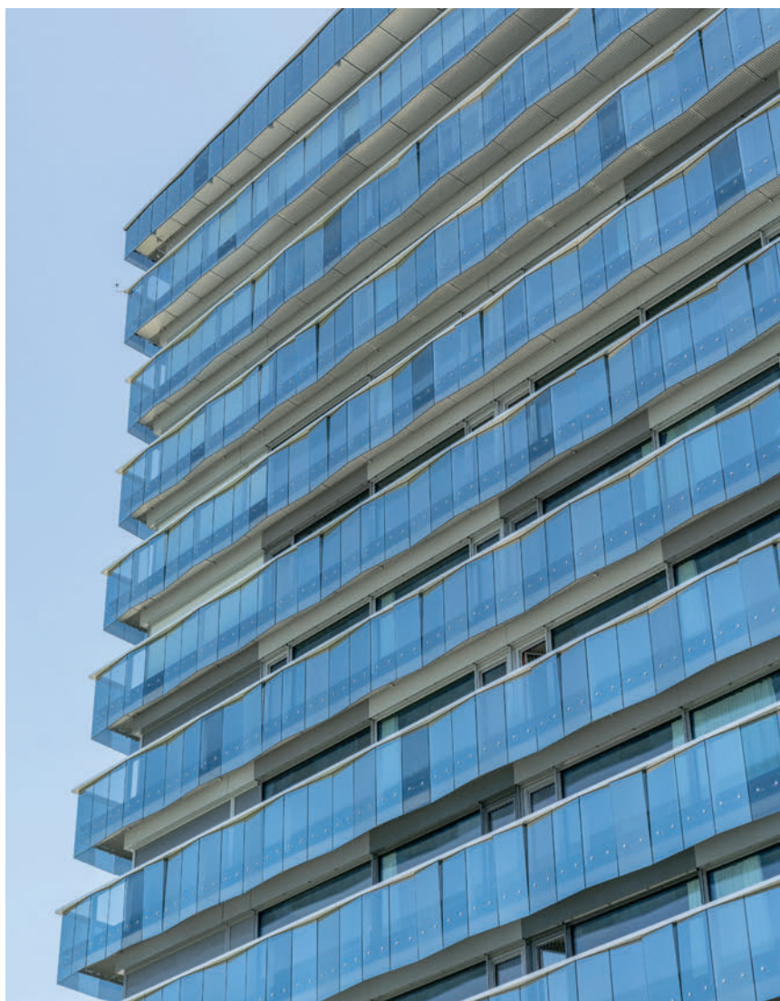
Beim Stadtspital Triemli führen in allen 18 Geschossen Laufstege mit Gitterrostböden um das Gebäude.
