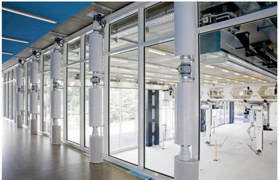
Pfosten-Riegel-Brandschutzverglasung mit Aussicht in die Robotik-Halle.
