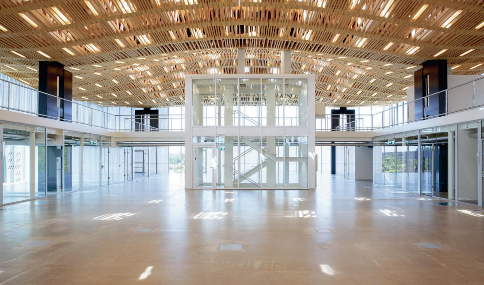
Im Zentrum die mit Brandschutzglas EI60 ausgerüsteten, lichtdurchflutenden Treppenhäuser. Das sequenzielle Dach darüber verknüpft digitale Fertigungstechniken mit nachhaltigen Baumaterialien.
