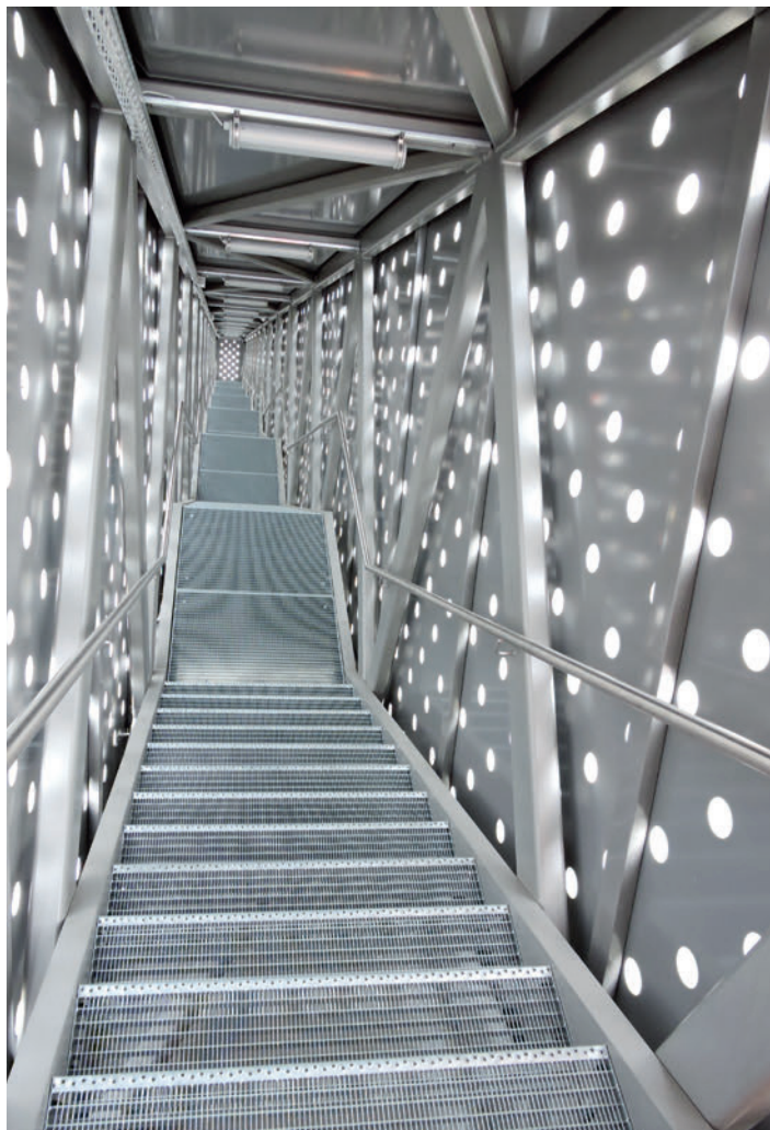
Auch verschiedenste Erschliessungstrepfen sind mit Gitterrosten eingekleidet.
