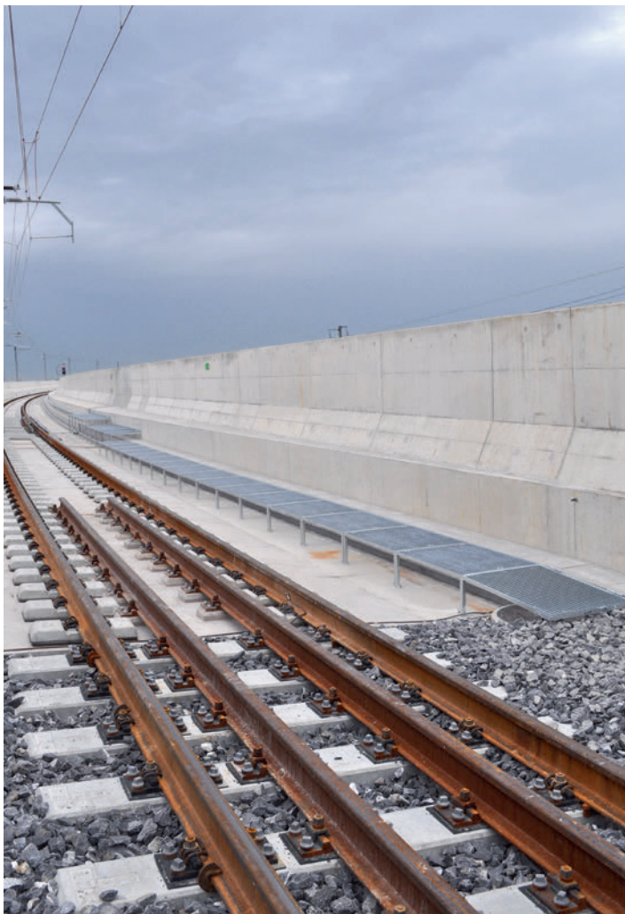
Hauptziel war die Sicherstellung des Evakuierungswegs für Fahrgäste.
