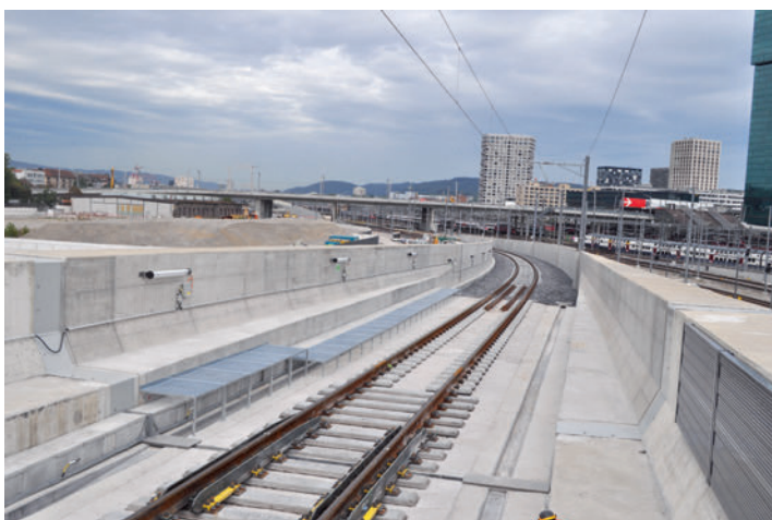
Zusätzlich dienen die Perronwinkel mit ihren Gitterrosten als Dienstweg für die SBB.
