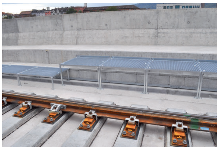
Mit angeschweissten Stützen reihen sich die Gitterroste nahtlos aneinander.
