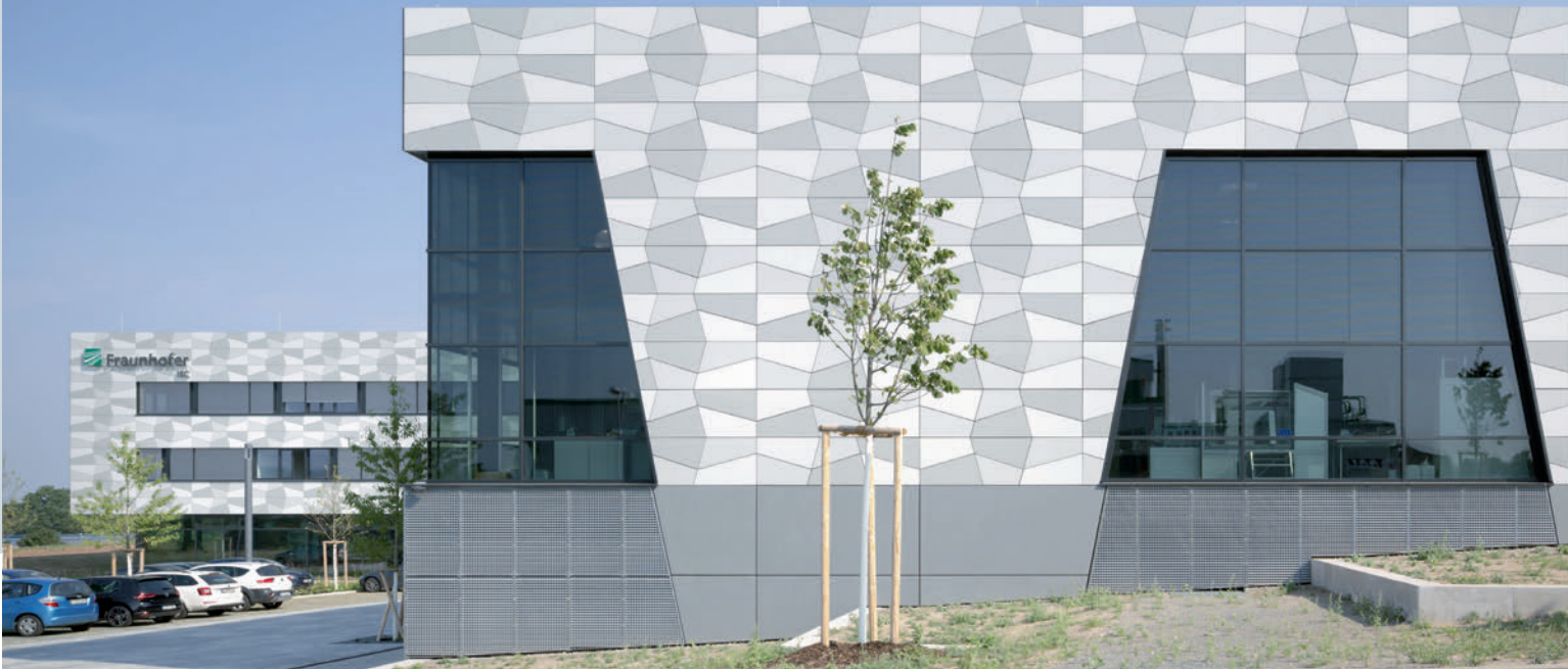
Bei den konischen Hallenfenstern kam Okasolar F U von Okalux zum Einsatz.
