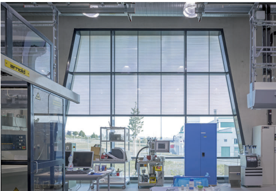
Im Scheibenzwischenraum des leistungsfähigen Lichtlenksystems sind feststehende Lamellen integriert.
