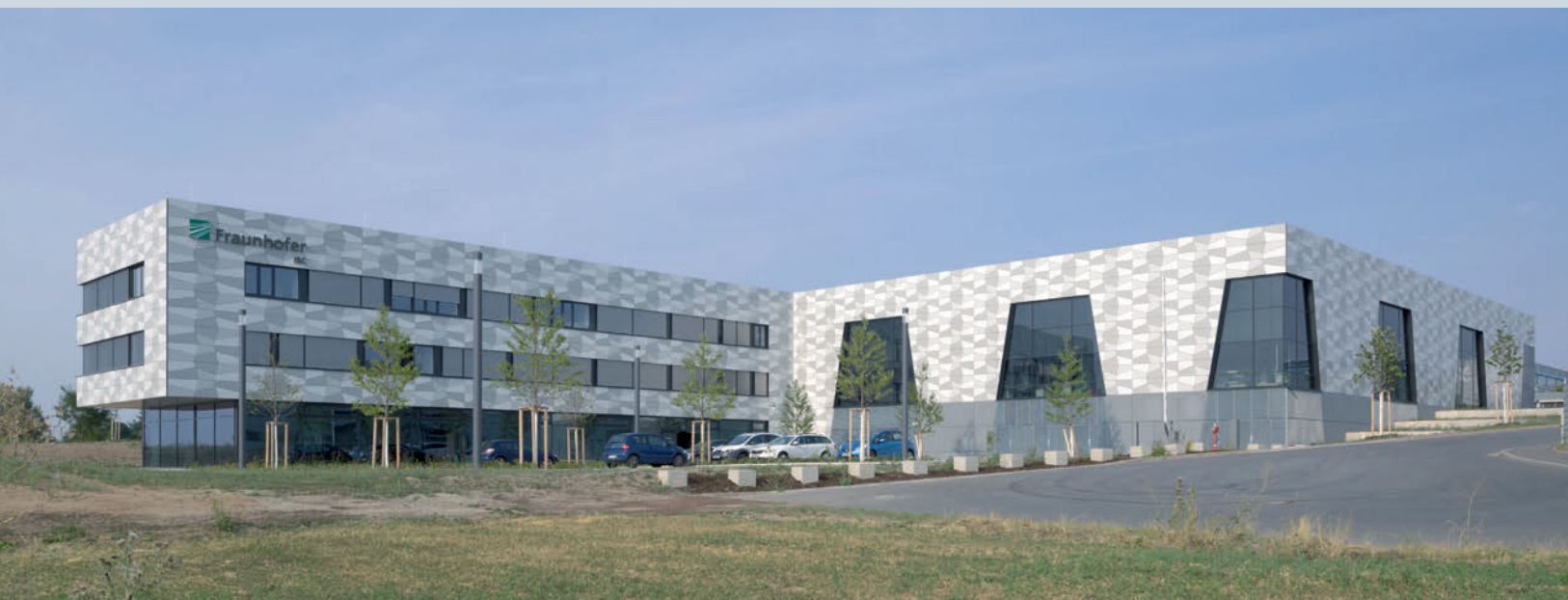
Das ganze Gebäude ist mit Keramikfliesen eingekleidet. Speziell sind die Netzmuster und die abwechselnden Farbtöne.
