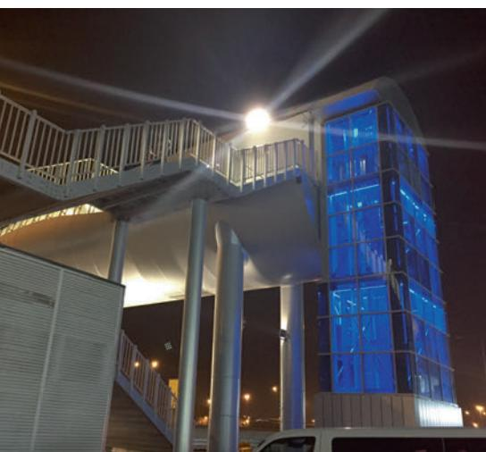
Neben der eigentlichen Brückenkonstruktion umfasst das Projekt zwei Treppenaufgänge aus Aluminium sowie zwei Aufzüge, die mit einem Glas-Aluminium-Turm umhüllt sind.
