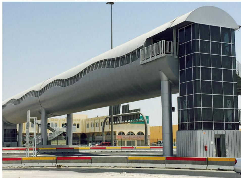
Das Bauwerk, das die East Industrial Road überbrückt, besteht aus zwei 42 m langen freitragenden Elementen und hat eine lichte Breite von 4 m.
