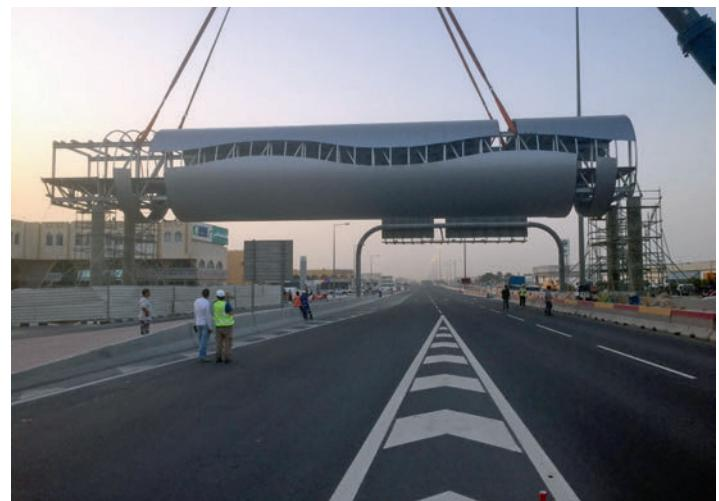
Mehrere kleinere Kräne wurden zur Unterstützung eingesetzt, um die beiden Elemente nah genug in den Einschwenkbereich zu bringen.
