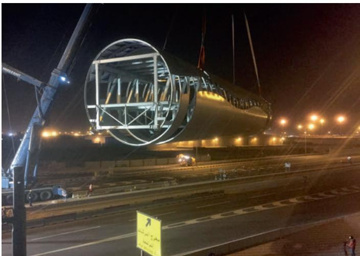
Wegen des hohen Gewichts von rund 40 t pro Brückenteil wurde der grösste in Katar verfügbare Kran – ein 500 t-Modell – gebucht, um das Bauwerk einzuschwenken.
