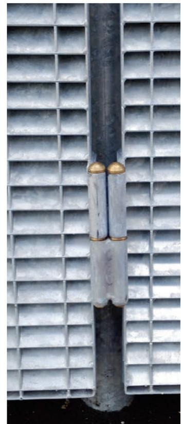
Die Drehbänder sind direkt an den Gitterrost-Rahmen angeschweisst.
