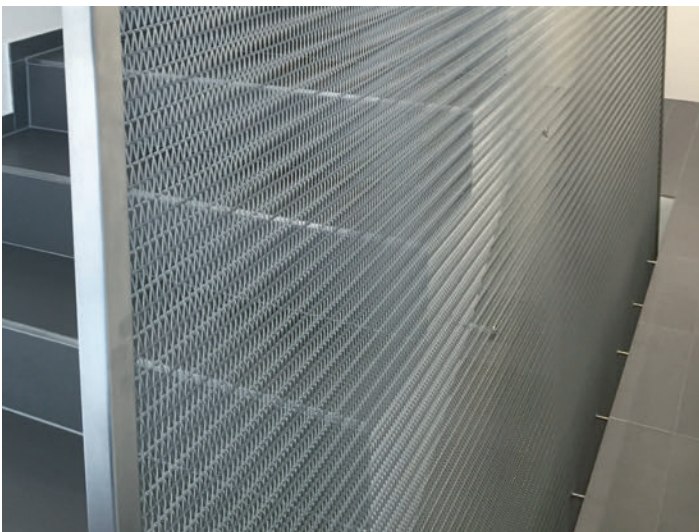
Punktueller Befestigung und Kantenschutz des Spiralgeflechts. Fixation ponctuelle et protection des bords du treillis en spirale.
