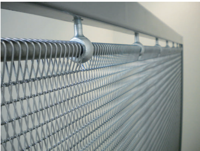
Die Metallgewebe sind oben hängend. Les toiles métalliques sont suspendues.
