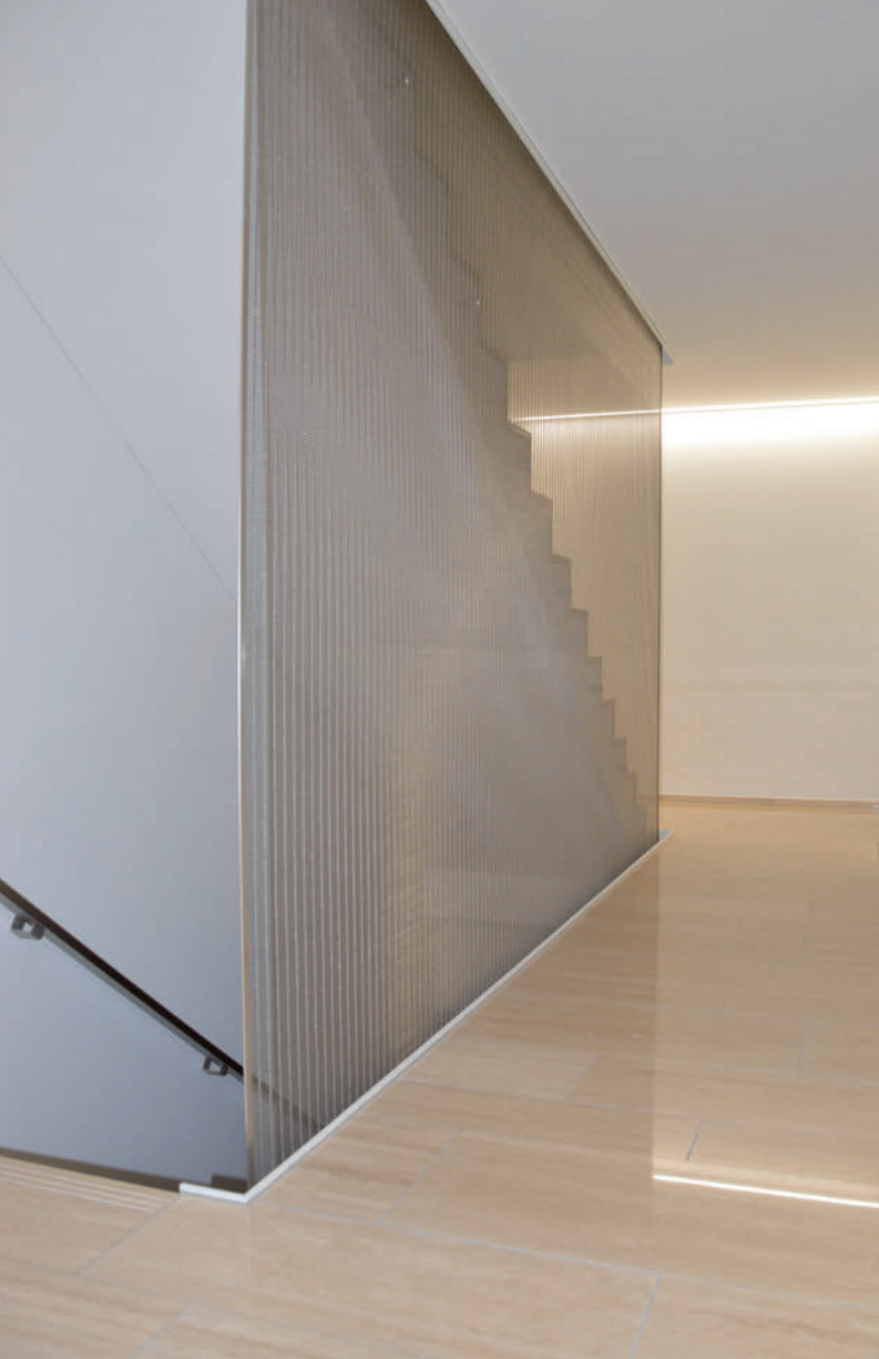
Verkleidung eines Treppenauges. Habillage d'un jour d'escalier.
