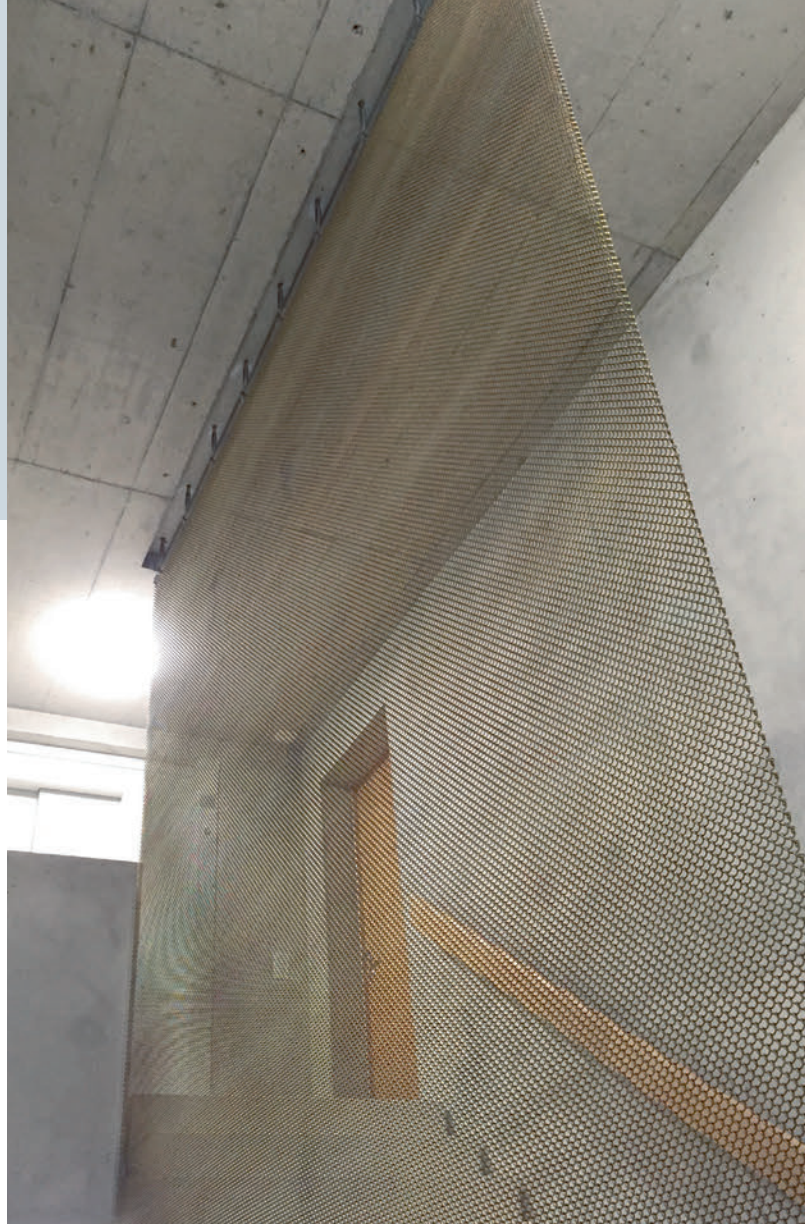
Das Metallgewebe bietet höchste Sicherheit im Treppenhaus und wirkt dennoch sehr transparent. La toile métallique assure une sécurité maximale dans la cage d'escalier tout en maintenant la transparence.
