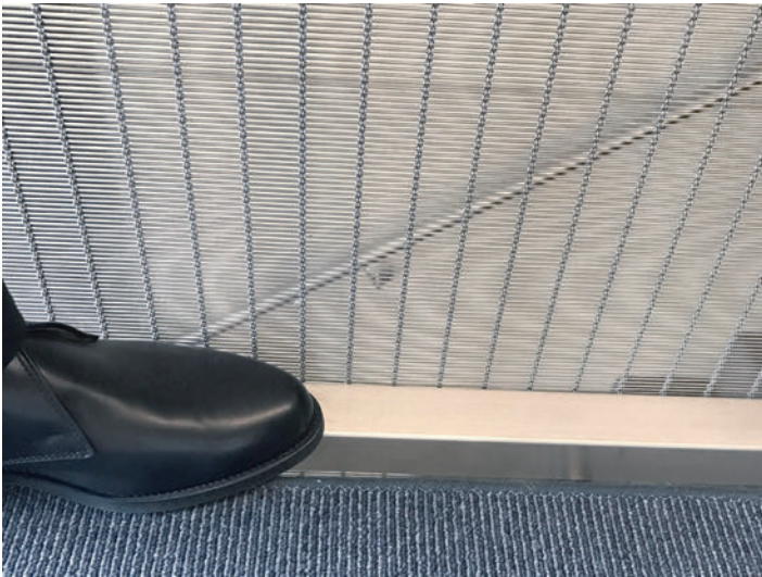
Eine Befestigung an das Treppenpodest ist zwingend. Une fixation aux paliers est obligatoire.
