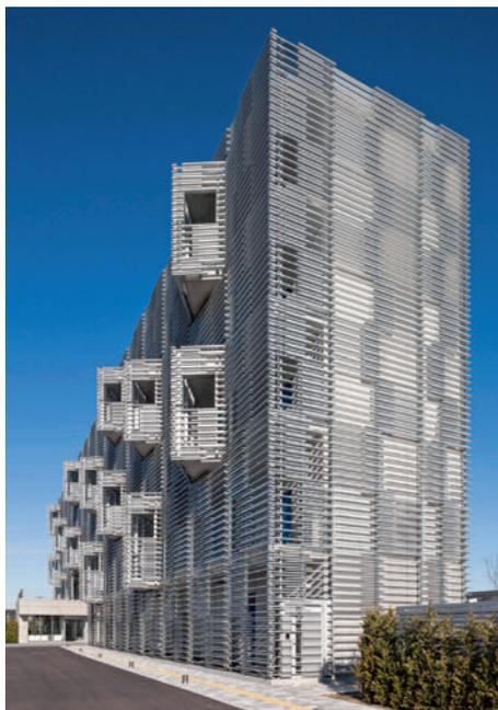
Den unregelmässig angeordneten Aluminiumprofilen orientieren sich an einem Höhenraster von 75 mm. Les profilés d'aluminium disposés de façon irrégulière suivent une trame verticale de 75 mm.
