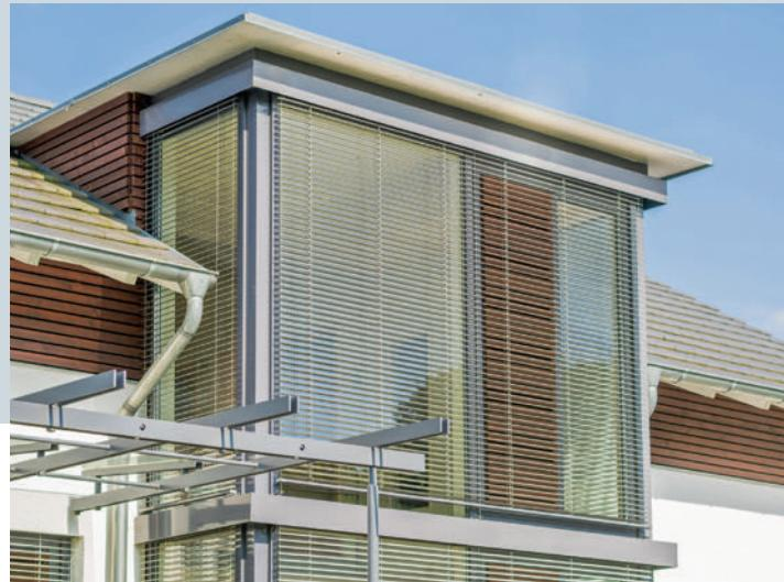
**Aussen angebrachte Raffstores eignen sich bestens für den geschlossenen Vertikalsbereich. Les stores à lames disposés à l'extérieur conviennent parfaitement pour les espaces verticaux fermés.**
