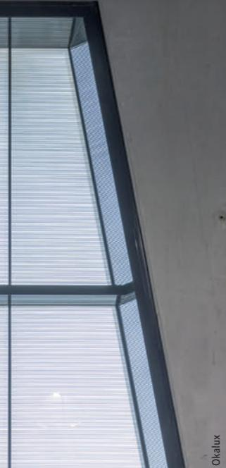
**Bewegliche oder feststehende Beschattungseinheiten lassen sich im Isolierglas einbauen. Das Bild zeigt eine Lösung mit integrierten, feststehenden Lamellen.**
