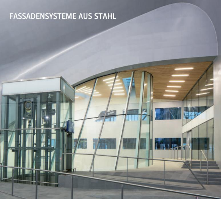
**Brandschutzkonstruktionen aus Jansen VISS Fire gewährleisten die von den Architekten angestrebte Transparenz auch im Inneren des Gebäudes.**
