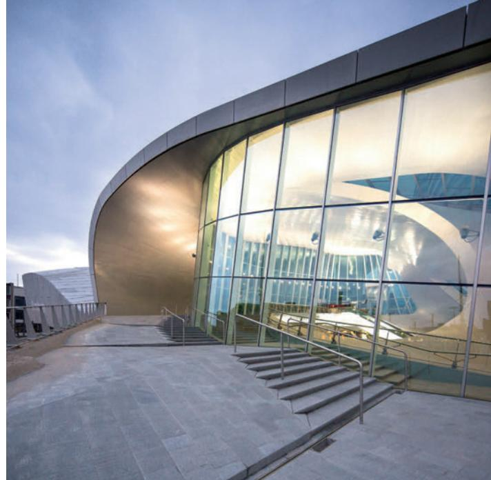
Neben dem wärmedämmenden Stahlprofilsystem VISS Basic brachte Jansen die unternehmenseigene Entwicklungskompetenz in das Projekt mit ein. Outre le système de profilés en acier à rupture de ponts thermiques VISS Basic, Jansen a intégré au projet les compétences de conception propres à l'entreprise.
