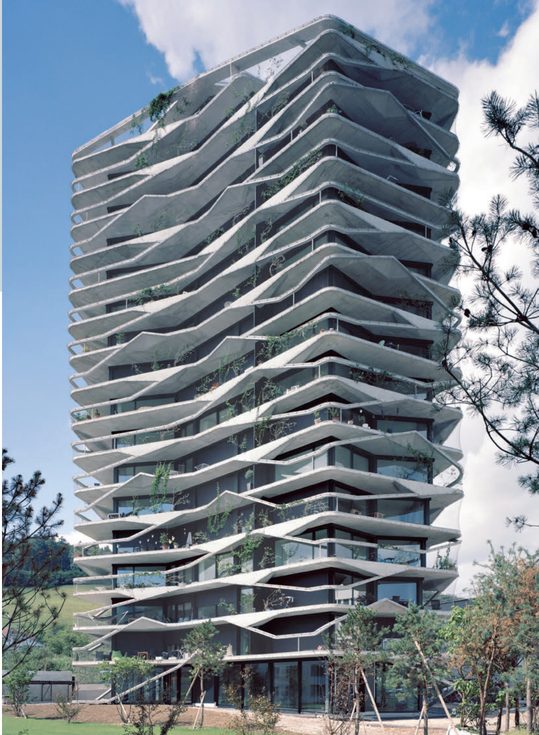
Das Edelstahlnetz erstreckt sich nahtlos über alle 16 Geschosse. Le filet en acier inox exempt de transitions s'étend sur les 16 étages.
