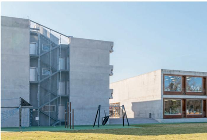
Die bestehende Stahltrappe ist mit Gitterrosten der Sprich - mit Flachrandeinfassung - eingekleidet.
