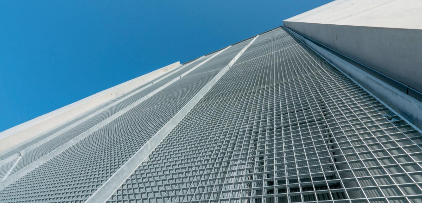
Die einzelnen Gitterroste weisen Längen bis zu 6 m auf.
