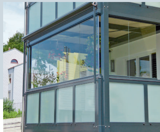
Transparente Verglasungen erweitern die jährliche Nutzungsdauer eines Balkons um Monate. Des vitrages transparents étendent de plusieurs mois la durée d'utilisation annuelle d'un balcon.
